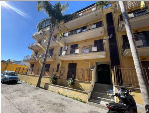
Fotografia n. 1 _ Prospetto su via A. Raucci
