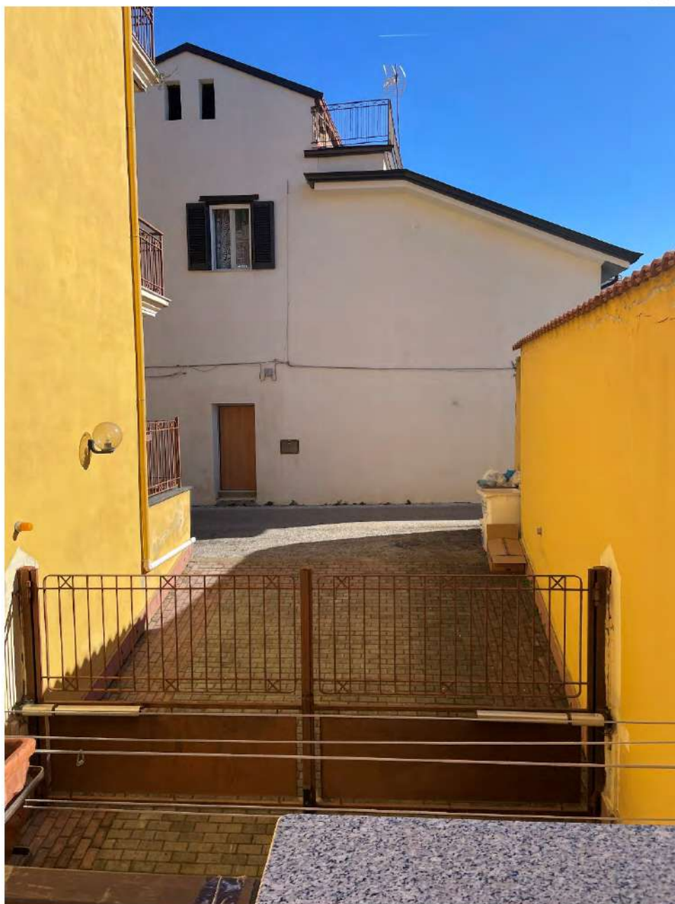
Fotografia n. 6 _ Rampa di accesso all'interrato, vista dal terrazzo esclusivo antistante la camera da letto
