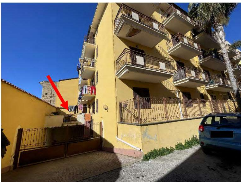
Fotografia n. 2 _ Ingresso carrabile al fabbricato; nel retro, indicato dalla freccia, il terrazzo esclusivo del LOTTO UNICO
