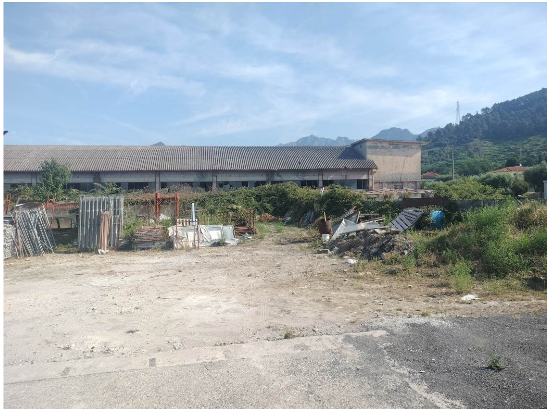
Vista del piazzale
