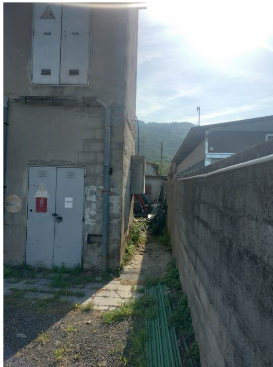
Vista della cabina Enel di altra Proprietà e del manufatto realizzato in assenza di titolo edilizio
