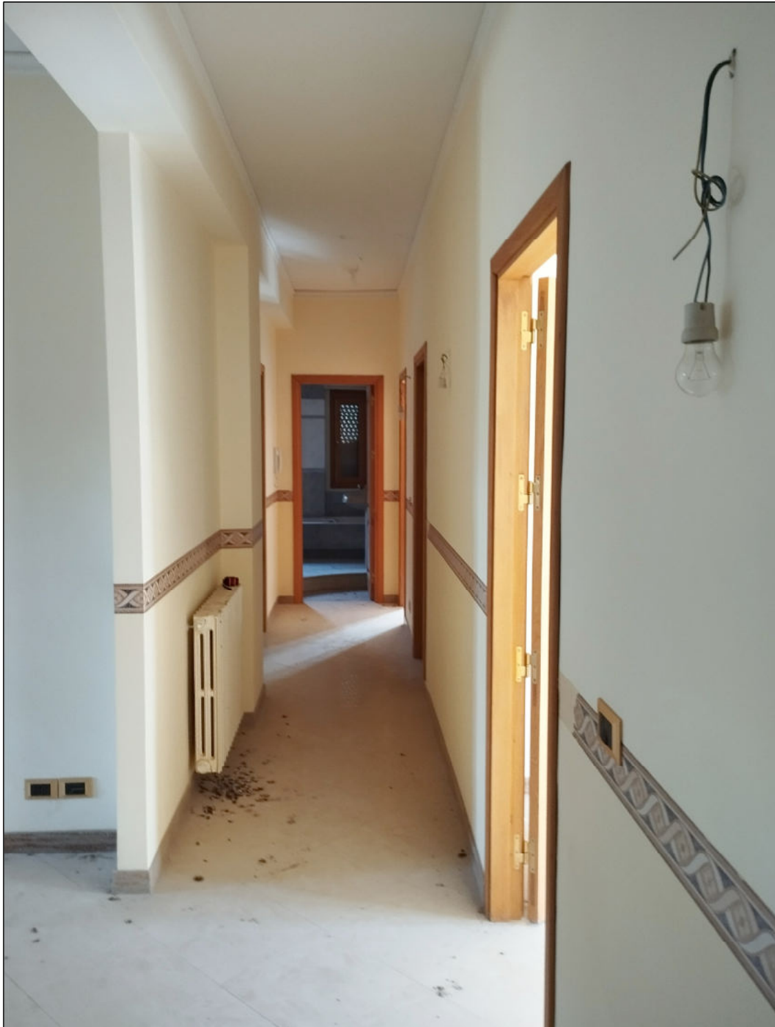
corridoio vista verso la zona notte
