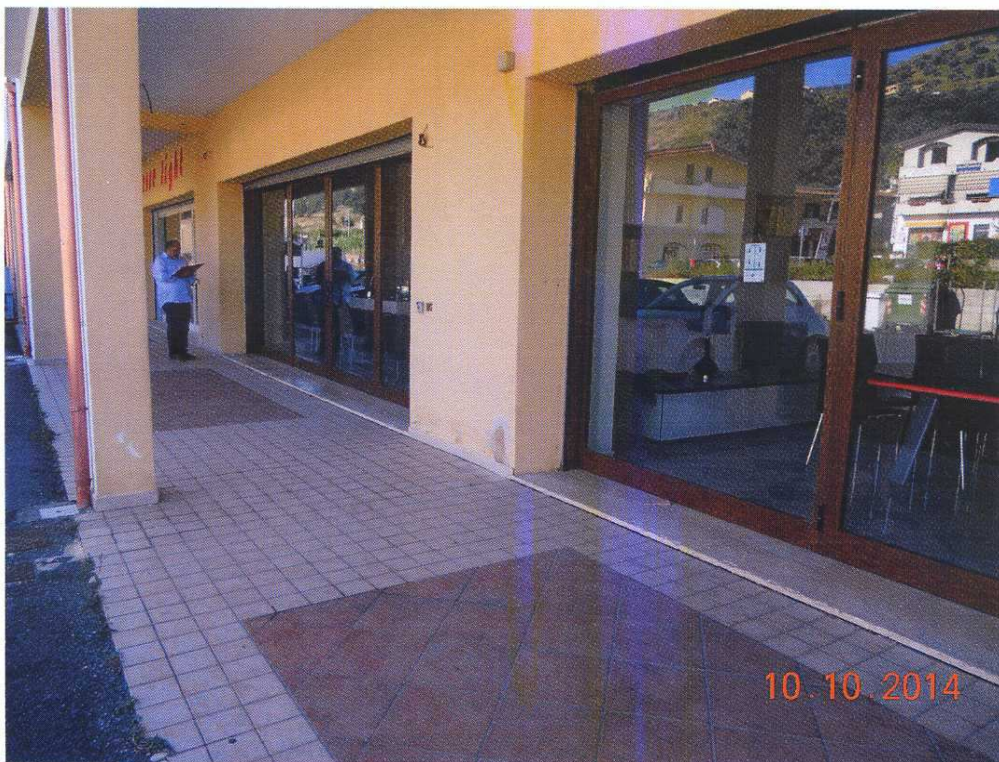
Fotografia n. 7 – Prospetto Est, locali commerciali
