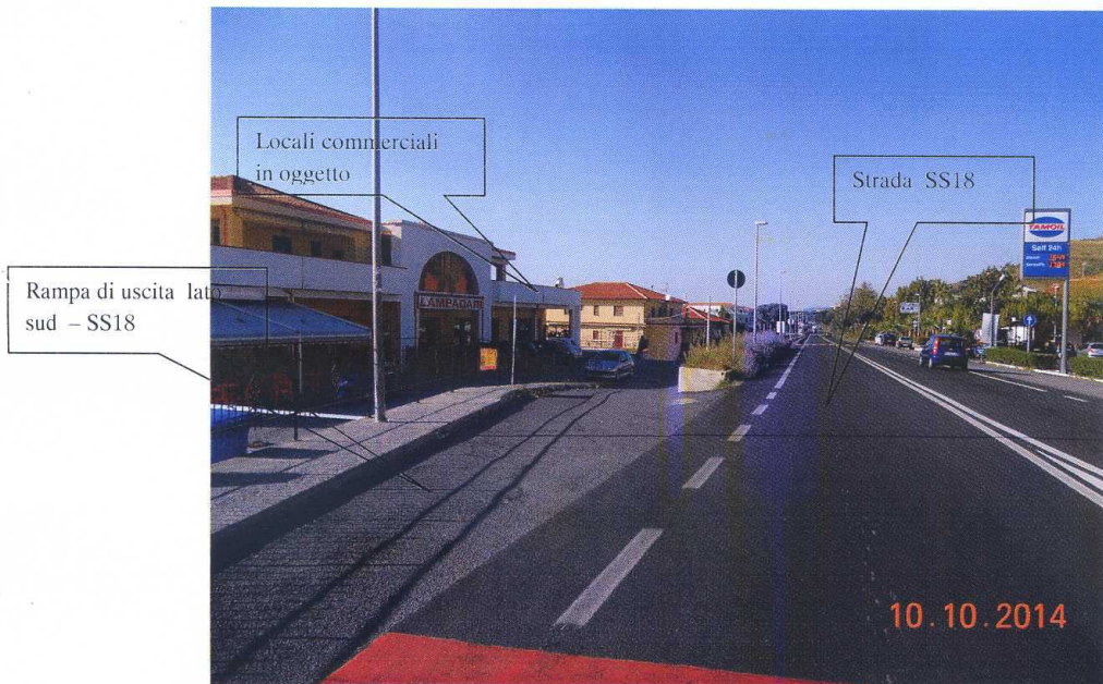
Fotografia n. 23 – Prospetto Est, rampa di uscita lato sud – SS18
