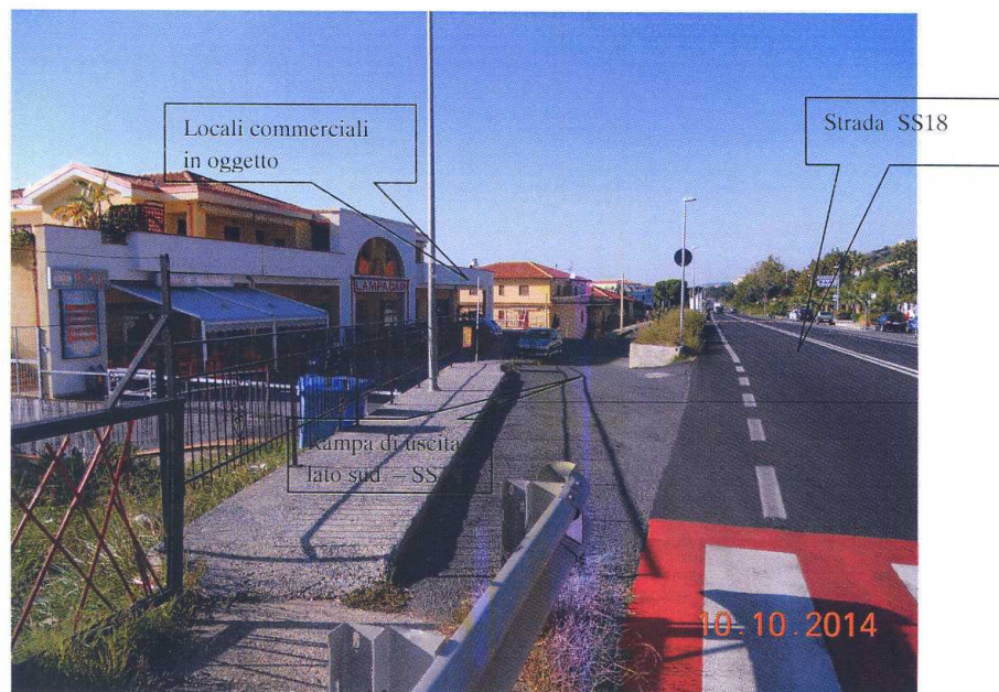
Fotografia n. 24 – Prospetto Est, rampa di uscita lato sud – SS18
