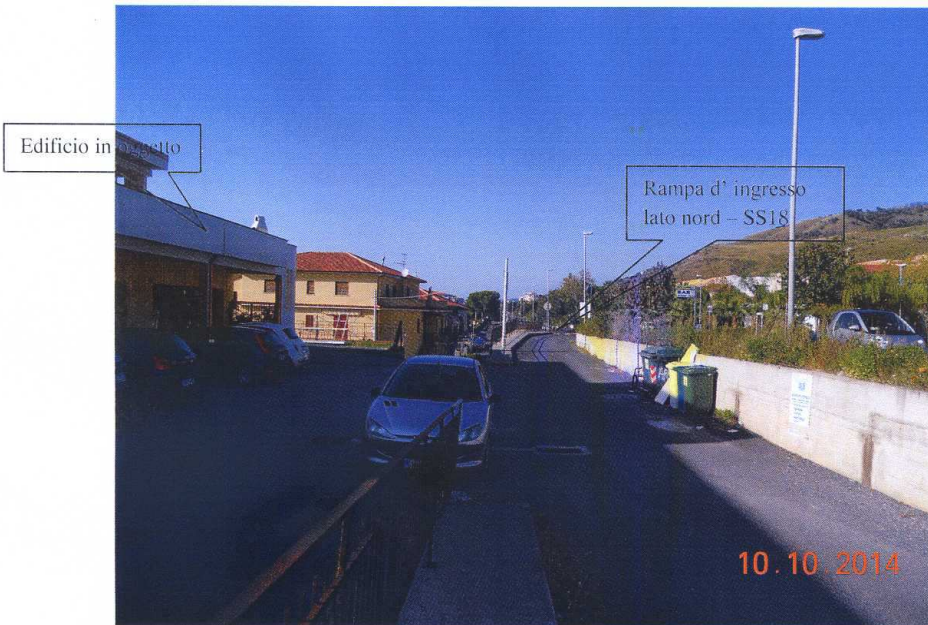
Fotografia n. 21 – Prospetto Est, rampa d' ingresso lato nord – SS18
