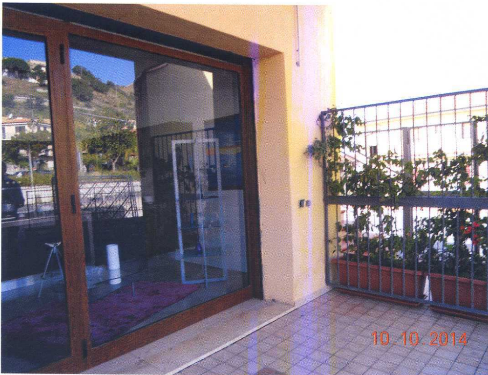
Fotografia n. 18 – Prospetto Est, particolare infisso esterno e rivestimento portico
