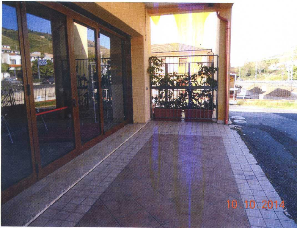
Fotografia n. 17 – Prospetto Est, particolare infisso esterno e rivestimento portico
