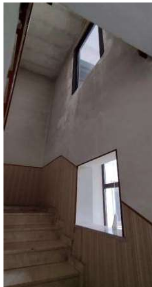
Dettaglio vano scala
