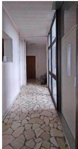
Corridoio accesso, ascensore
