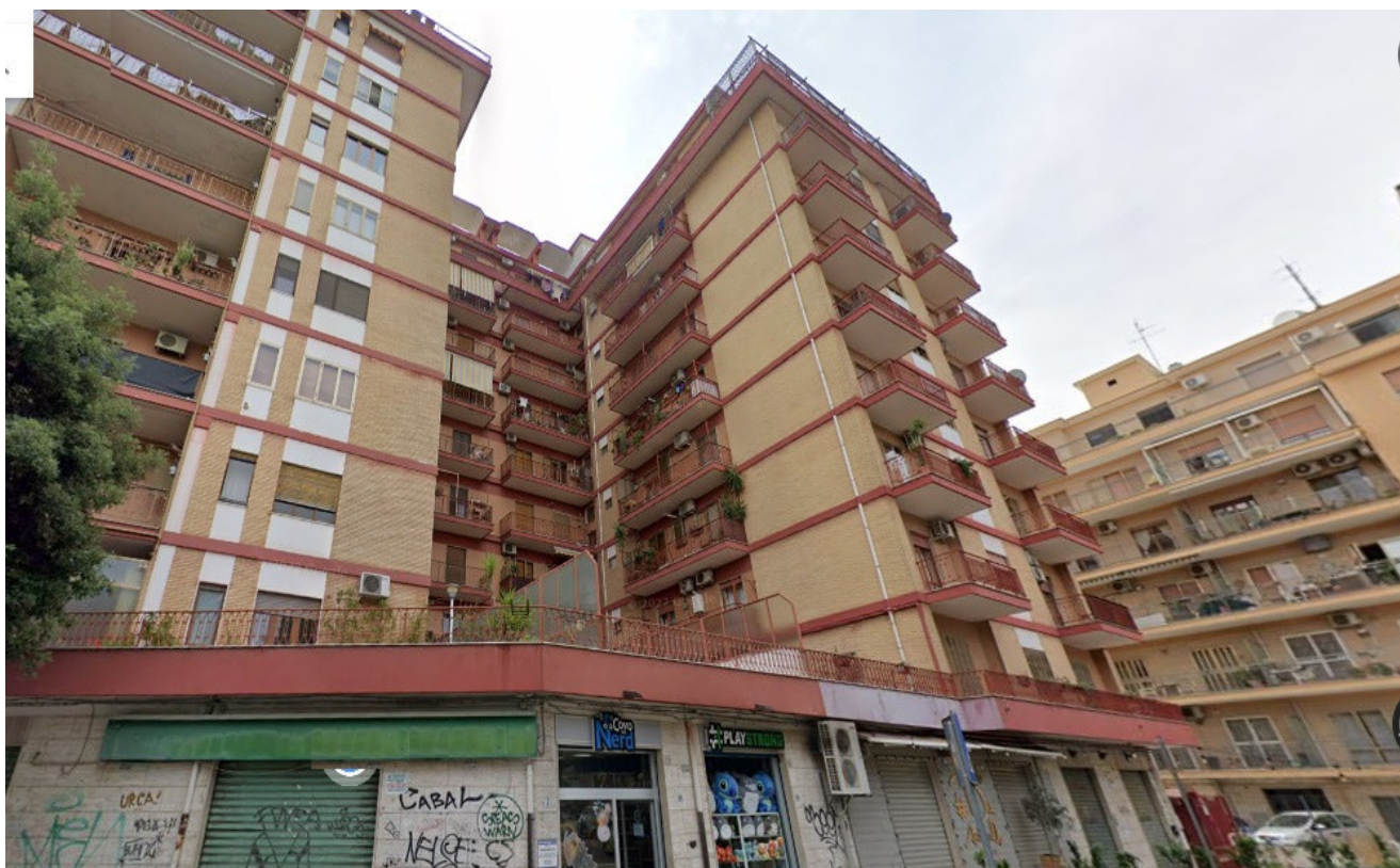
Vista Condominio dell'immobile oggetto di causa (piano 9)
