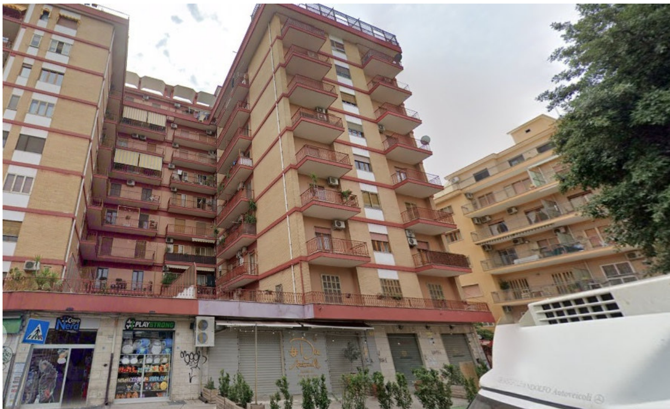
Vista Condominio dell'immobile oggetto di causa (piano 9)
