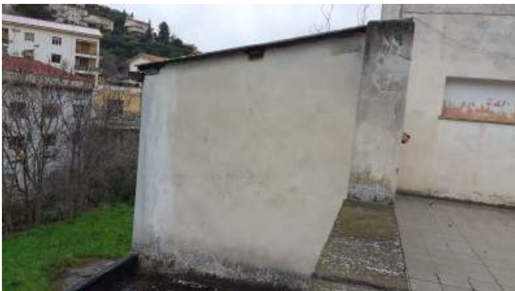
Esterno del vano scale del blocco uffici-sogliatoi
