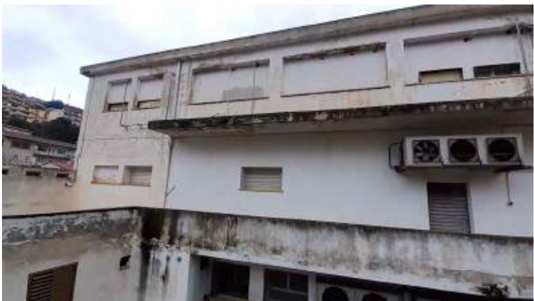
Piano terra e primo dell'opificio
