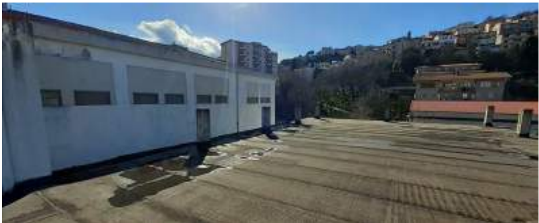
Copertura del "nuovo" opificio
