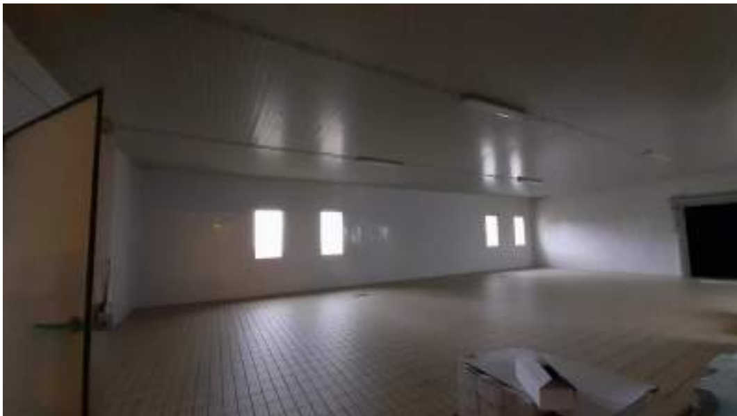
Piano terra, ampliamento, locale disimpegno
