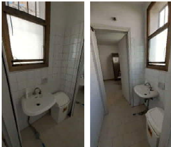
Servizi igienici per l'area spogliatoio
