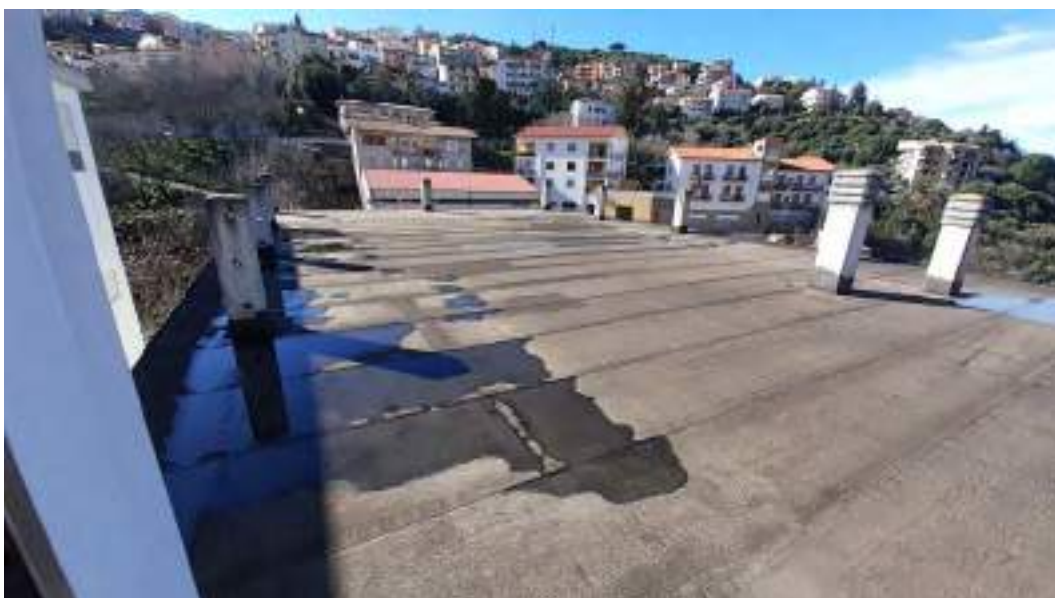
Copertura del "nuovo" opificio
