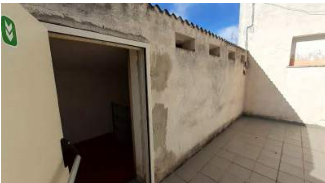
Ingresso al blocco uffici
