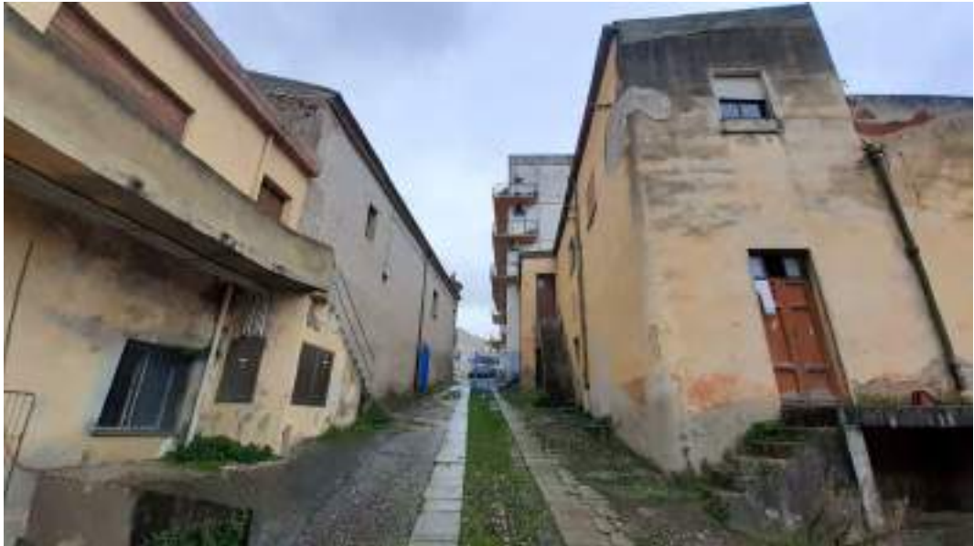
Entrata carrabile al piazzale comune
