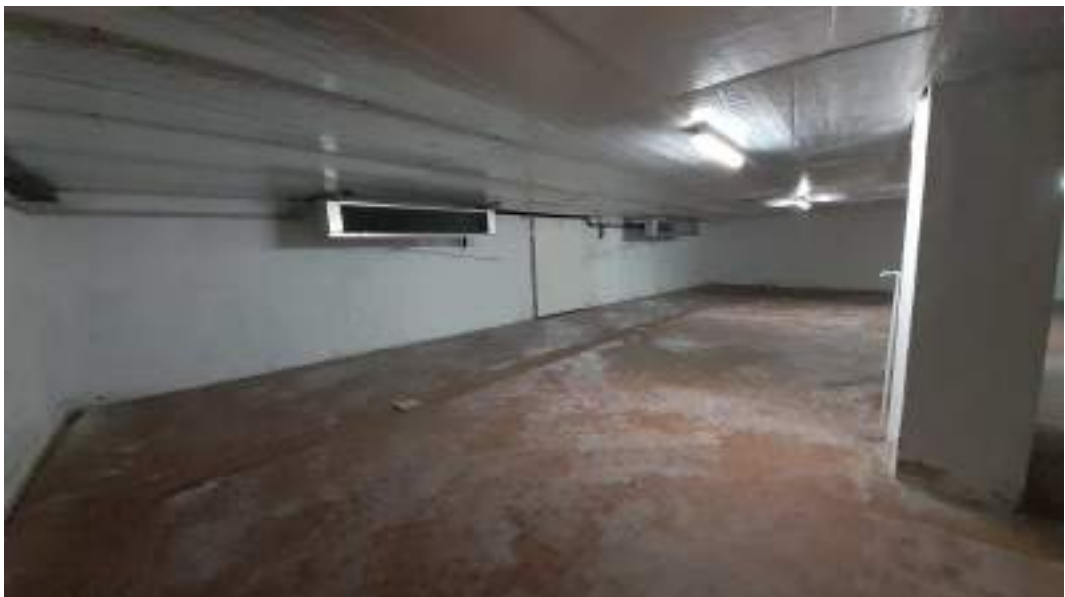
Bene n. 1, piano secondo seminterrato, deposito formaggi
