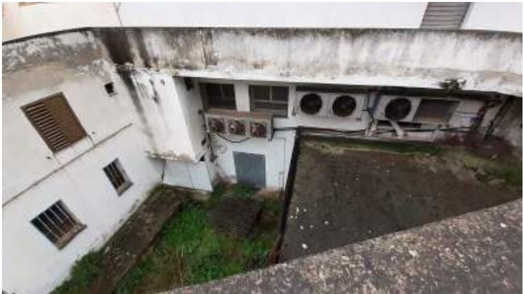
Locale seminterrato del blocco uffici-spogliatoi
