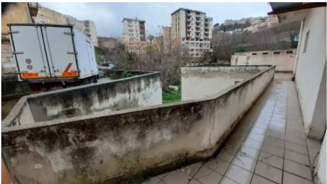
Accesso esterno al blocco uffici-spogliatoi
