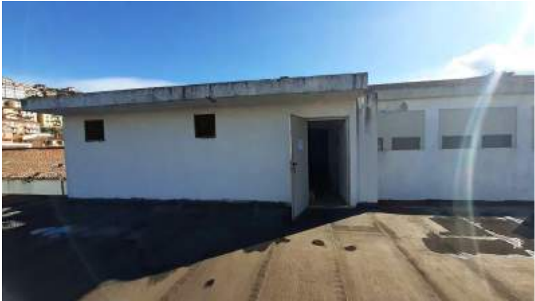
Accesso alla copertura dal secondo piano
