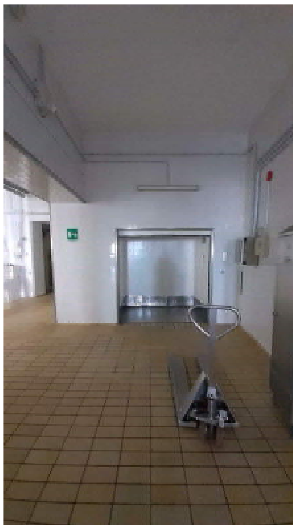
Piano terra, zona montacarichi, fianco locale lavorazione
