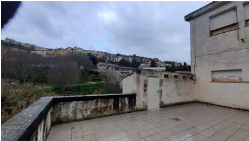
Ingresso al blocco uffici-sogliatoi
