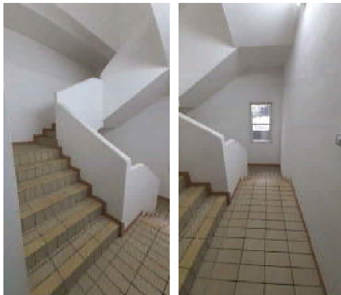
Vano scale di collegamento fabbricato ampliamento
