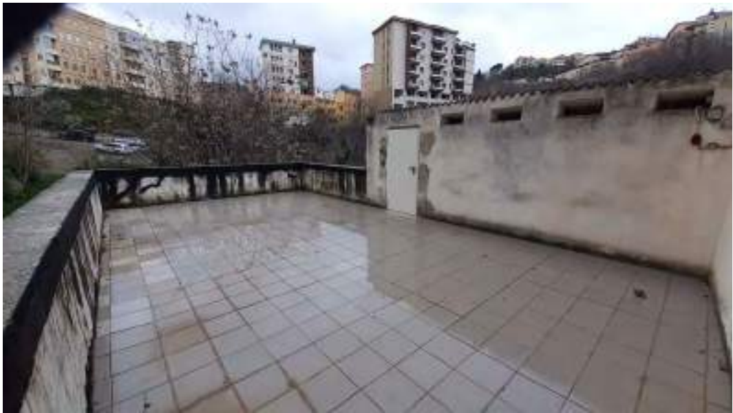
Terrazza blocco uffici-spogliatoi
