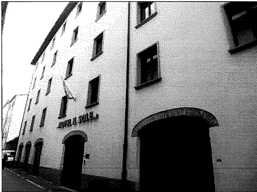
FOTO 3 - vista degli ingressi carrabili lato Via Norma Parenti
