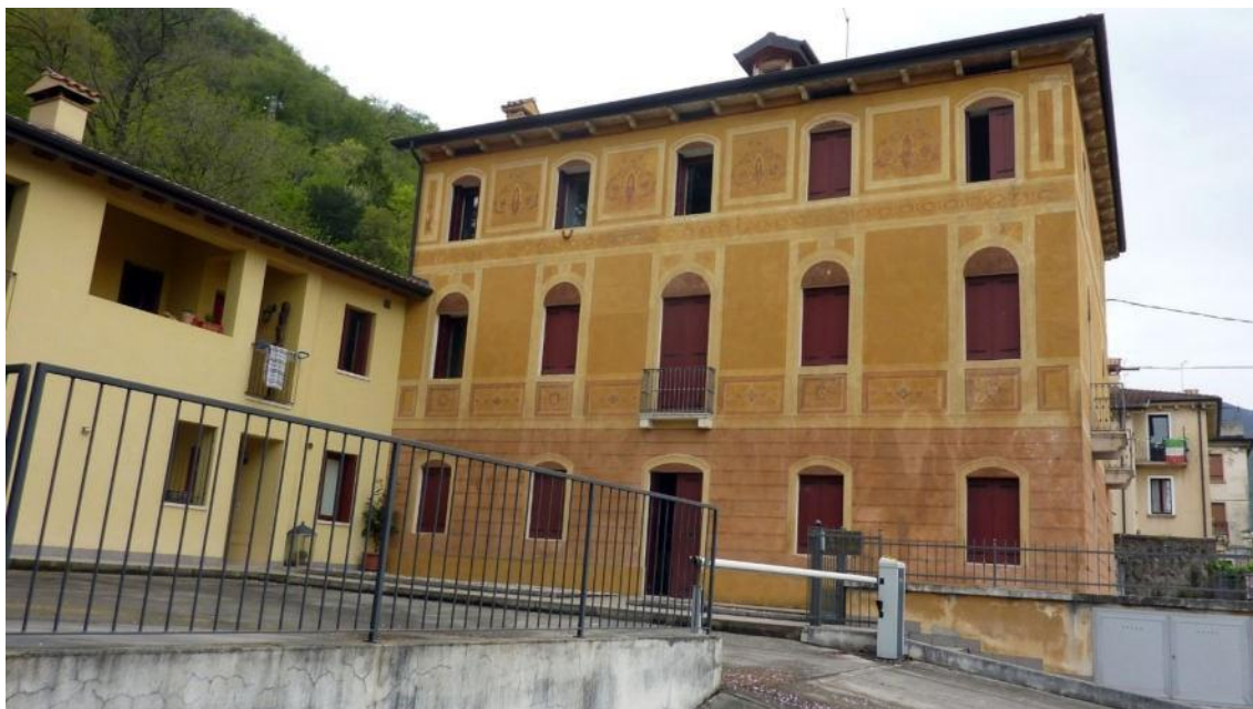
Vista intero edificio fronte sud-est
