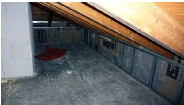
VISTA 3 sottotetto (sub 25)
