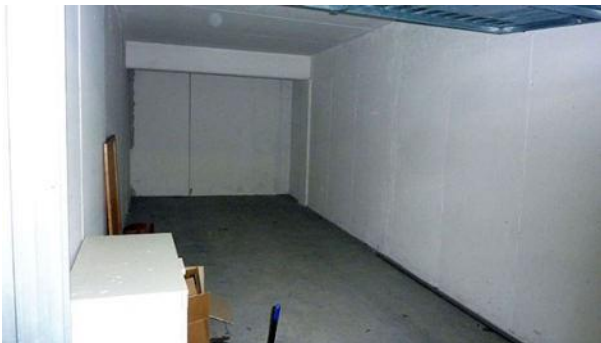
VISTA 8 autorimessa (sub 9)
