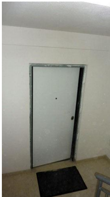
VISTA 6 (ingresso a sub 27)
