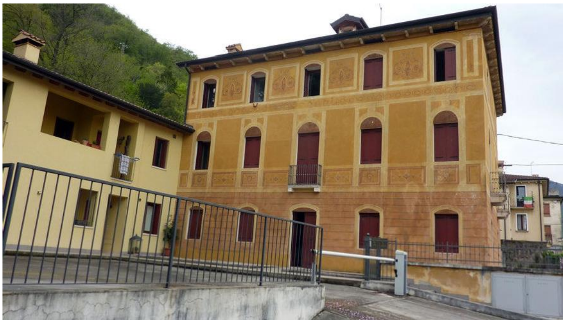
Vista intero edificio fronte sud-est
