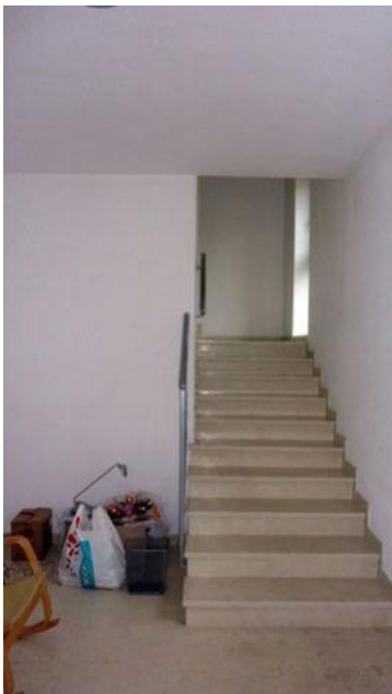
VISTA 5 (vano scala comune)
