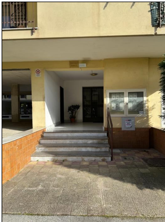
Foto 5 – Ingresso Fabbricato 2 Scala C
