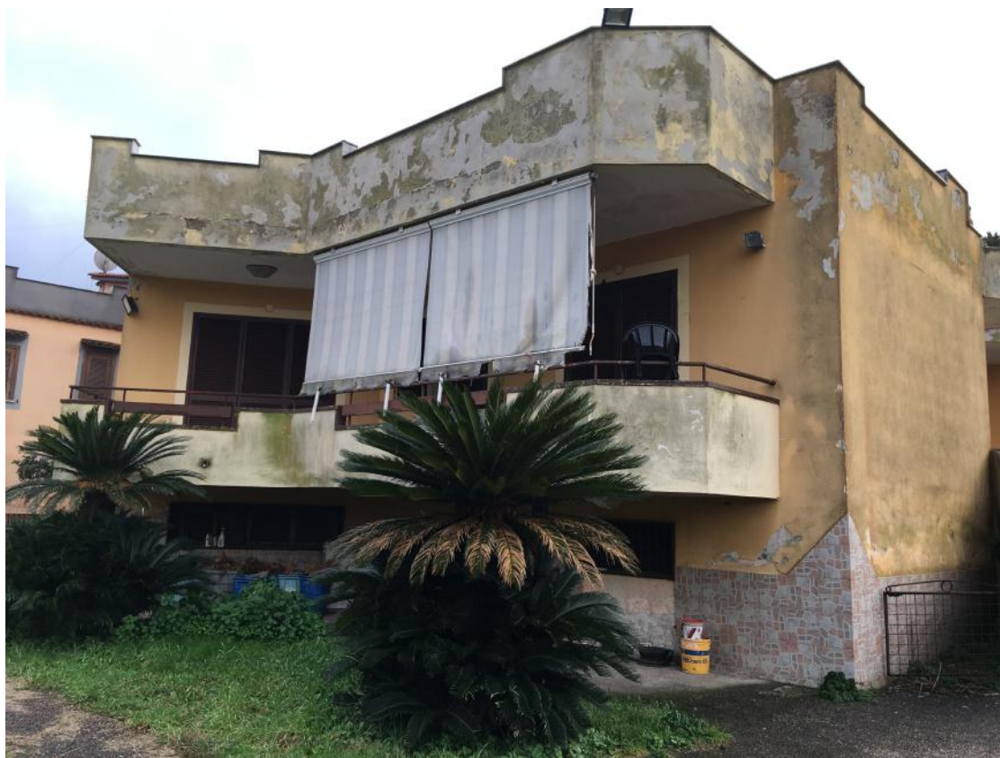
foto n.°1 – prospetto principale fabbricato
