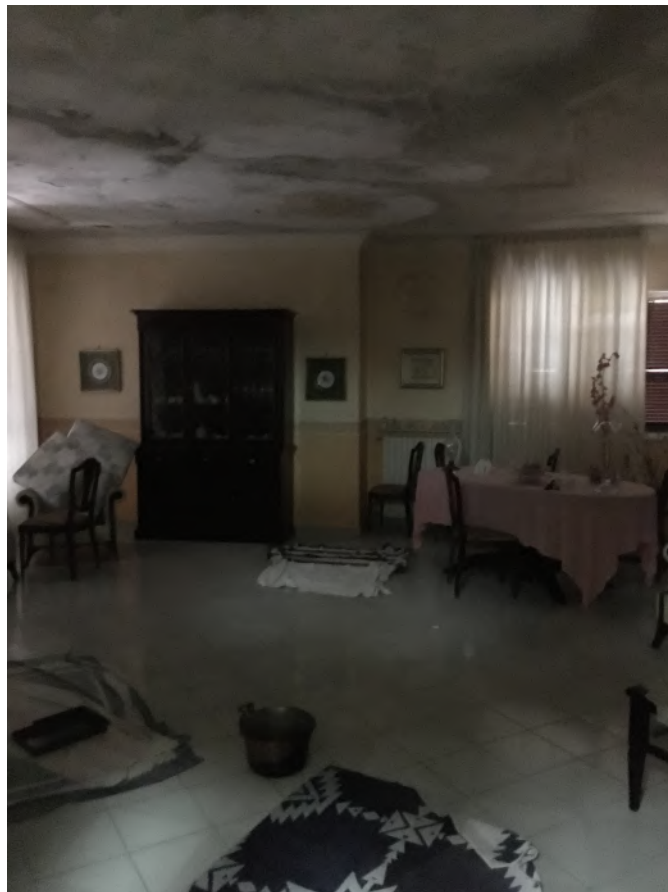
foto n.°6 – particolare vano utile primo piano
