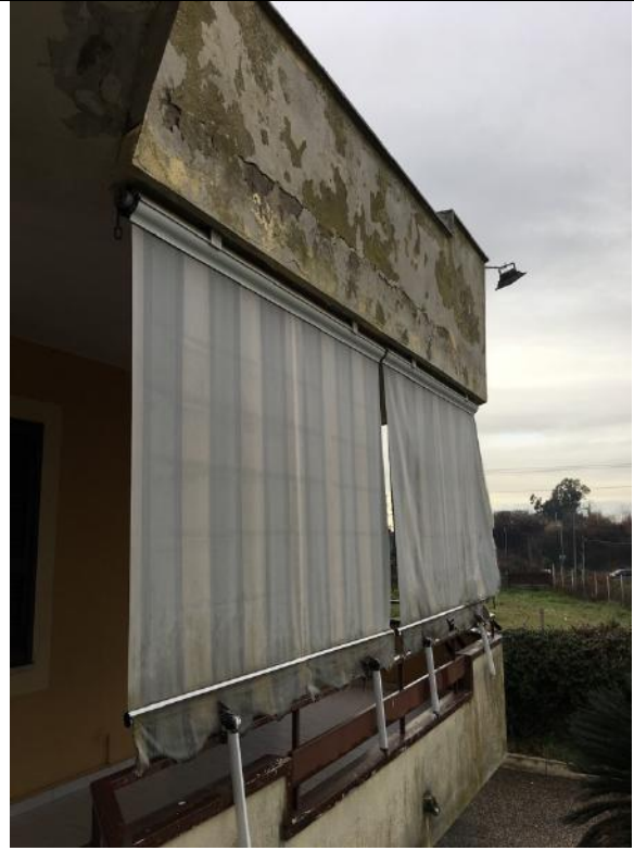
Foto n.2 – particolare tamponatura esterna
