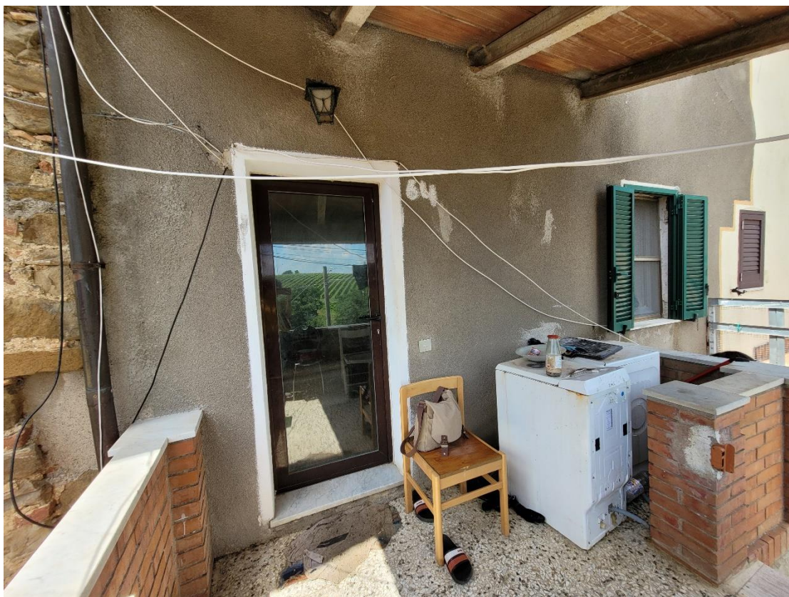
Fig. 7 – Terrazzino e ingresso piano primo (sub. 8)
