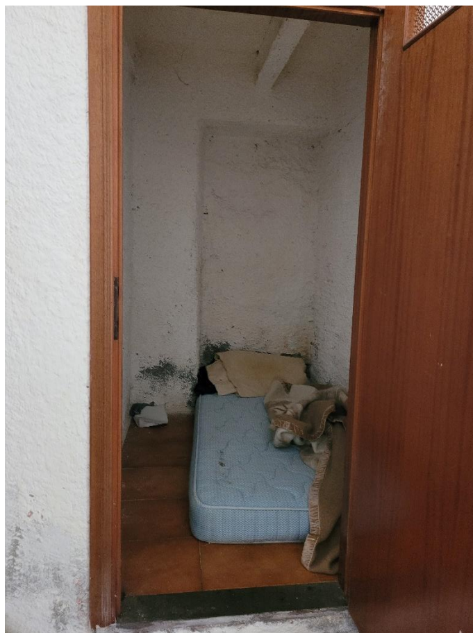
Fig. 5 – Ripostiglio piano terra (sub. 7)
