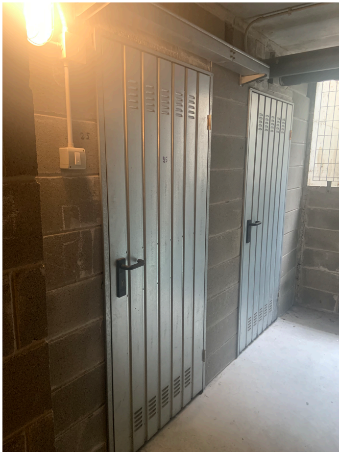
Ingresso cantina PS1
