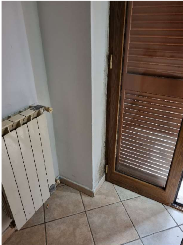
55) Particolare radiatore ed infisso
