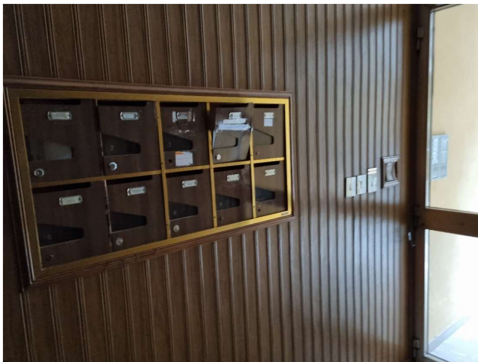
7) Atrio ingresso fabbricato
