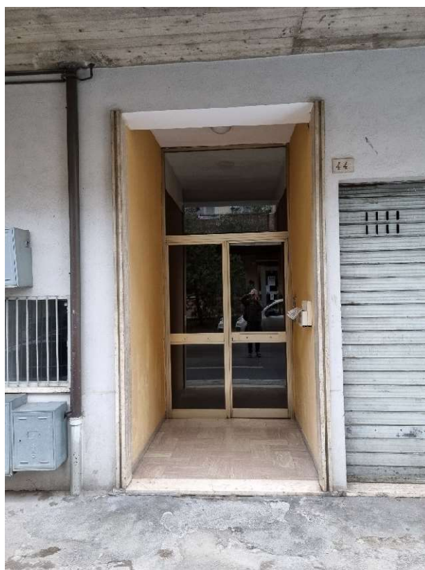
4) Ingresso fabbricato – Via Ettore Ricci 44
