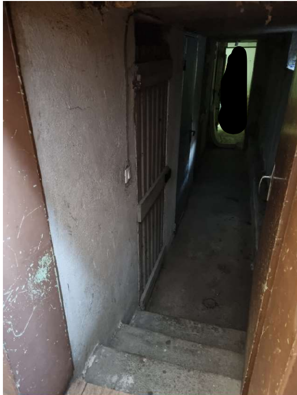
64) Corridoio accesso fondo
