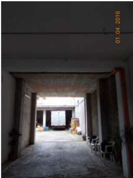
Ingresso al sub 2
