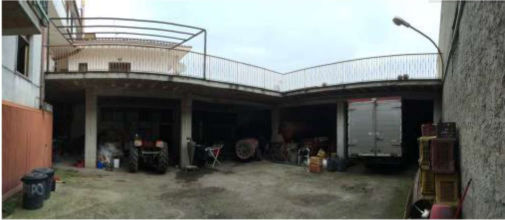
Vista del sub 2 dal sub 1
