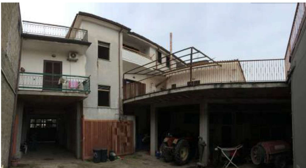
Vista del sub 2 dal sub 1
