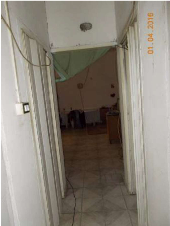
Foto 17 Vista del Locale Loc2 dal disimpegno i
