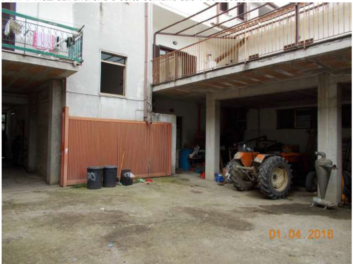
Foto 10 Vista dall'androne e corte comune sub 1 del locale Loc5
