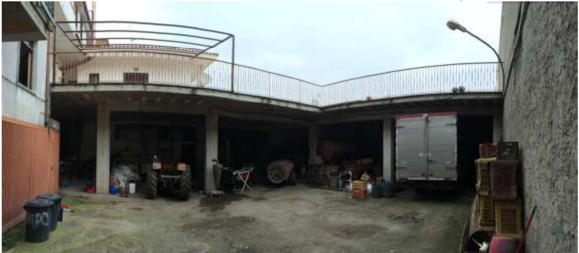
Foto 7 Vista dall'androne e corte comune sub 1 dell'immobile sub 2
