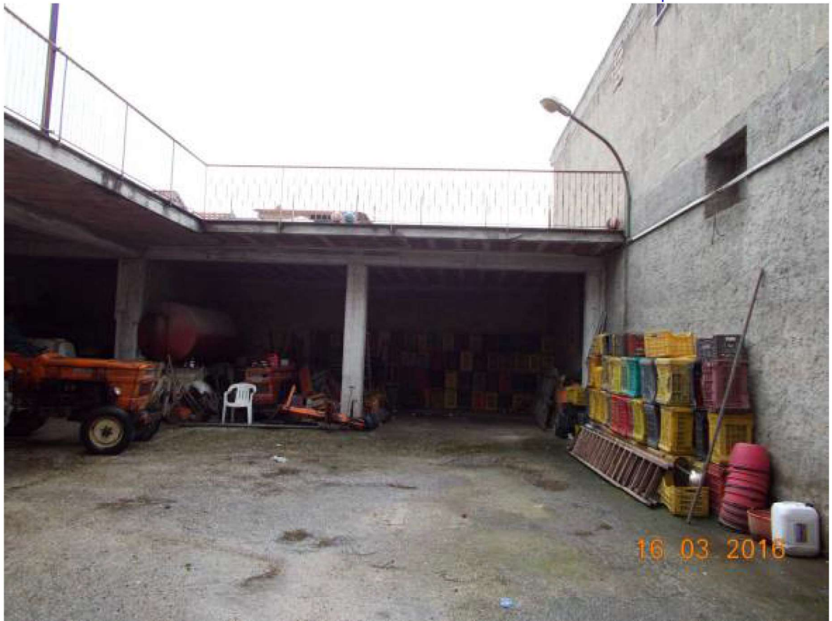
Foto 9 Vista dall'androne e corte comune sub 1 del locale Loc6
