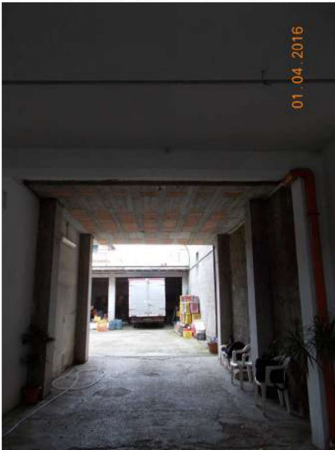
Foto 4 Androne e corte comune sub 1
