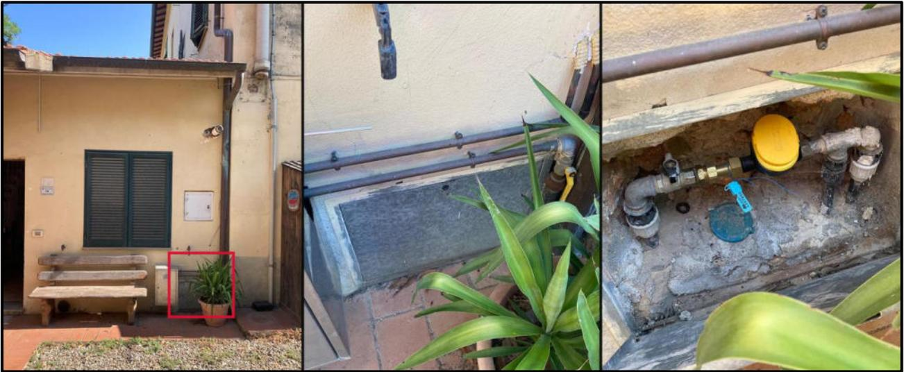
Impianto idrico: contatore in vano ricavato nella muratura esterna
