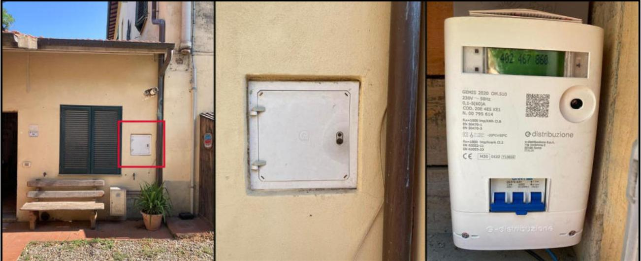
**Impianto elettrico: punto di fornitura con alloggiamento contatore nella muratura esterna**
