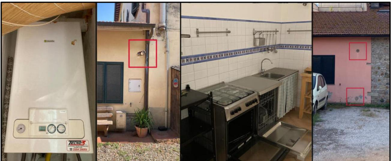
Impianto gas: caldaia con espulsione fumi, piano cottura, fori areazione e ventilazione.
