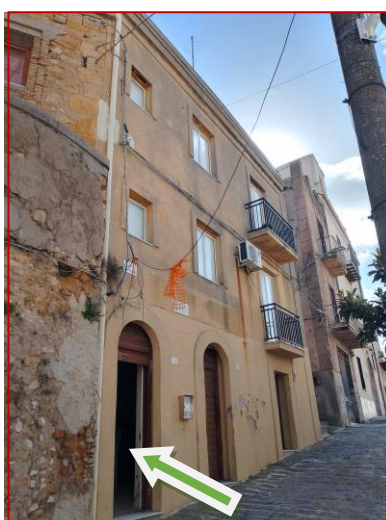
Vista da via San Giuliano accesso
