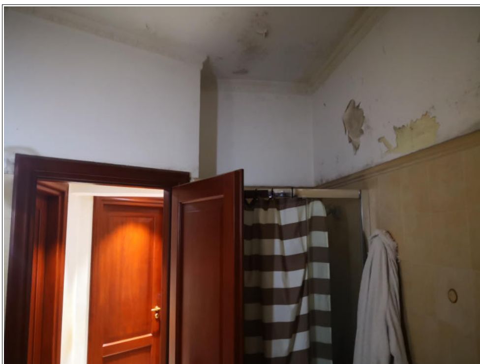
Foto n. 27: Interno | secondo piano | bagno | angolo doccia
