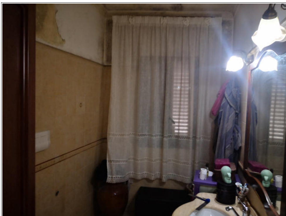
Foto n. 25: Interno | secondo piano | bagno
