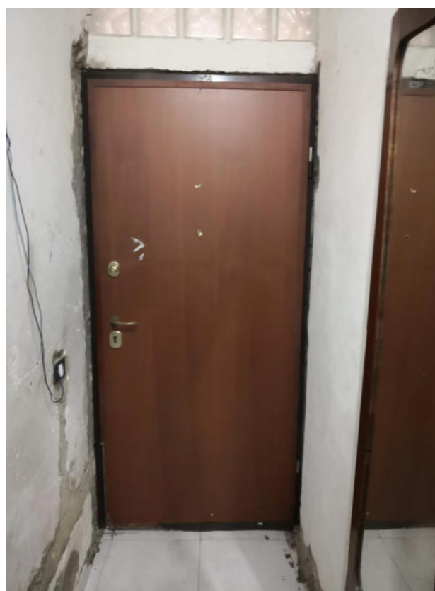
Foto n. 7: Interno | pianoterra | ingresso
