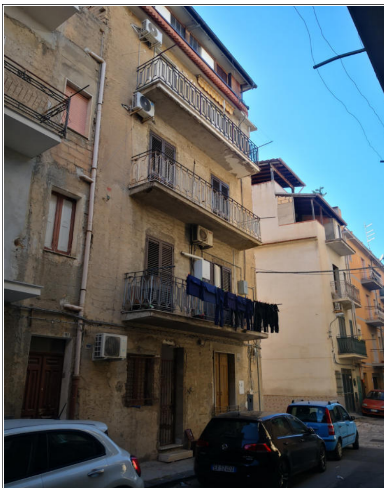
Foto n. 2: Esterno | via Monza | prospetto nord
