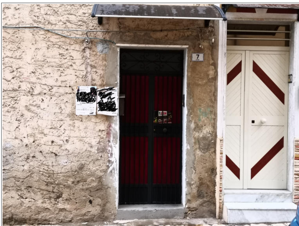
Foto n. 5 : Esterno | via Riesi n° 7 | prospetto ovest | ingresso dell'edificio
