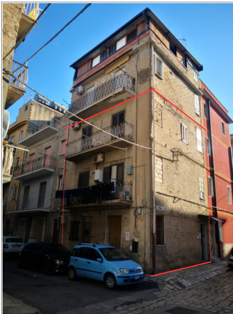
Foto n. 1: Esterno | via Monza (angolo via Riesi) | prospetti nord ed ovest
