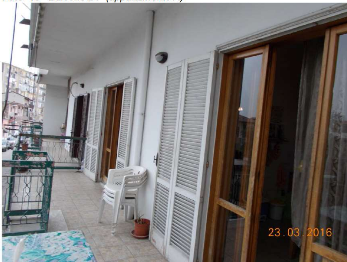
Foto 14 Balcone b1 (appartamento A)
