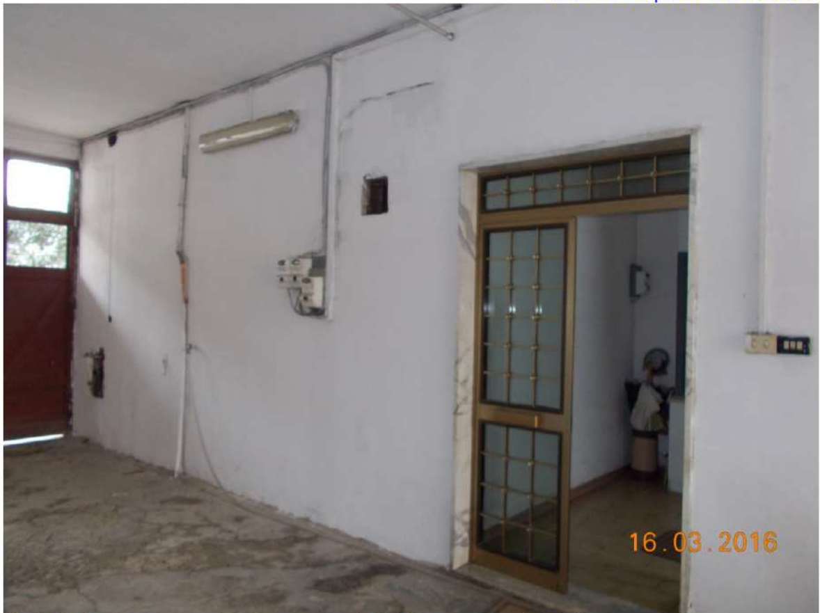
Foto 5 Androne e corte comune sub 1 ed accesso al sub 5
