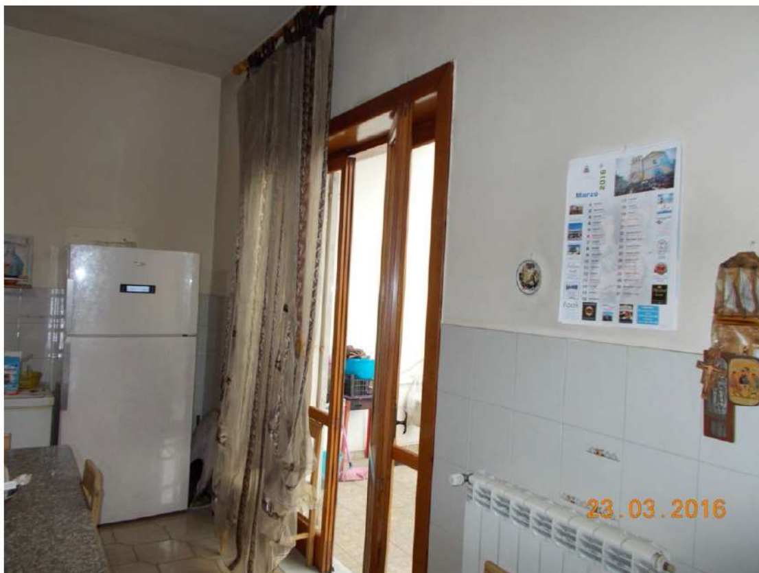
Foto 12 Il balcone b1 accesso dalla cucina (appartamento A)
