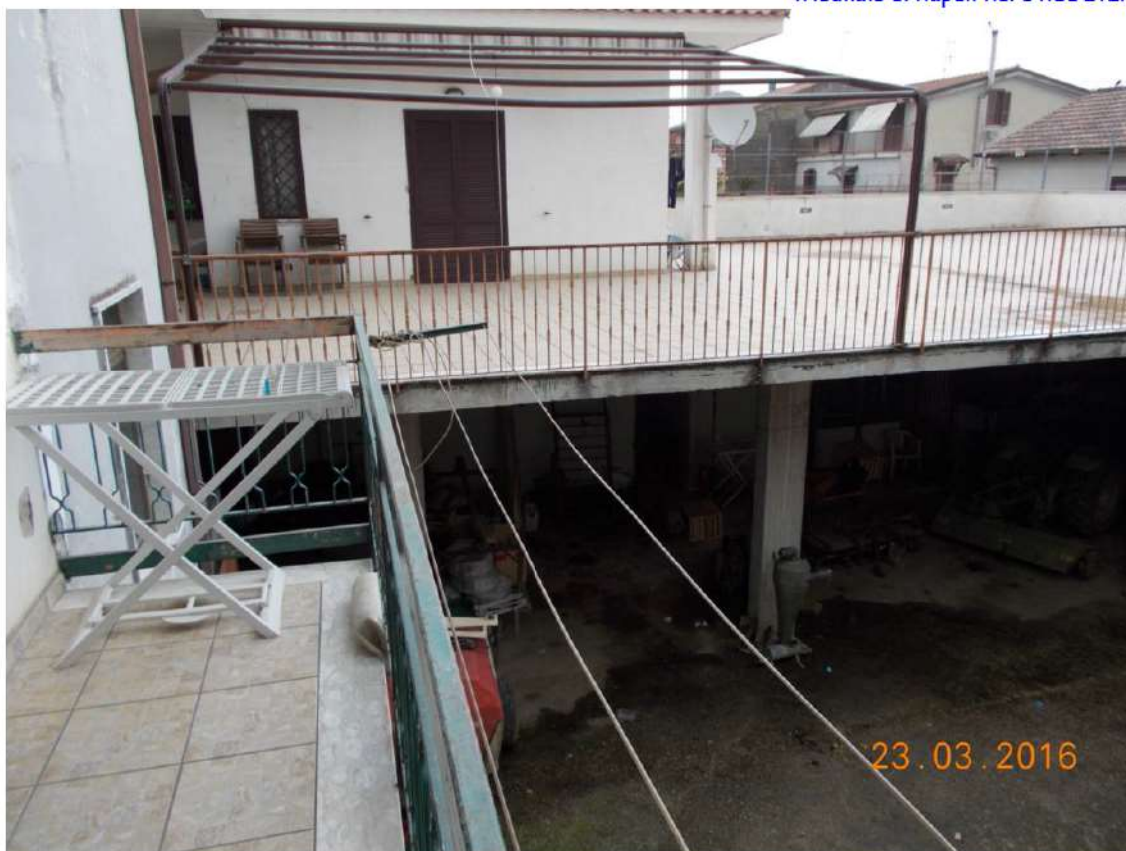
Foto 21 Balcone b2 (appartamento A)
