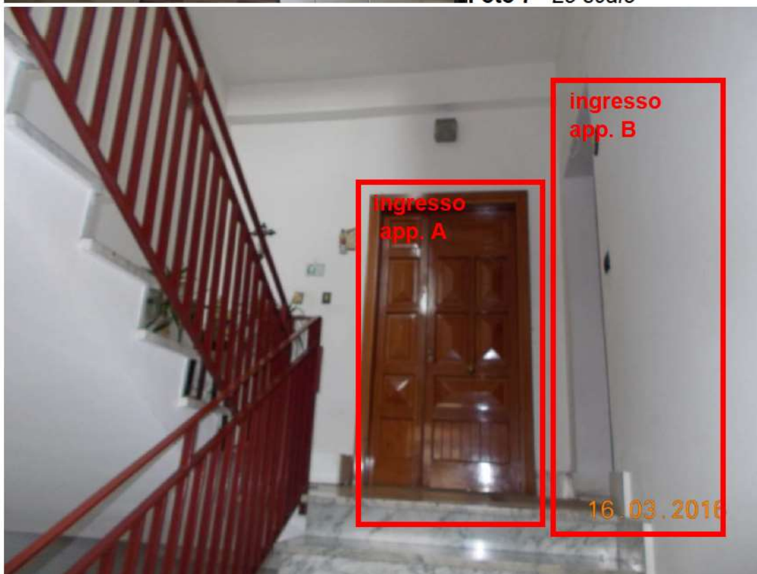
Foto 8 Ingressi al sub 5
