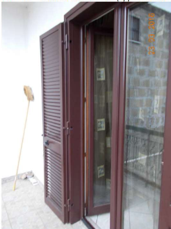
Foto 20 Balcone b2 (appartamento A)
