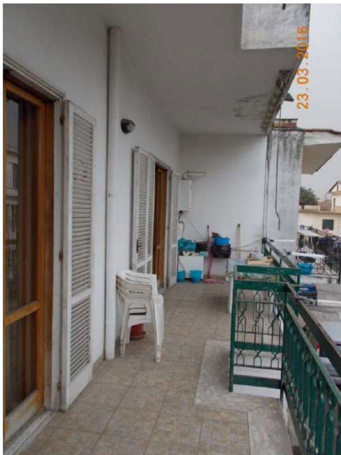
Foto 13 Balcone b1 (appartamento A)
