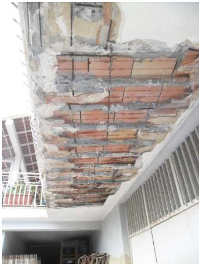
**Figura 11 - Degrado ballatoio prospetto Est**
