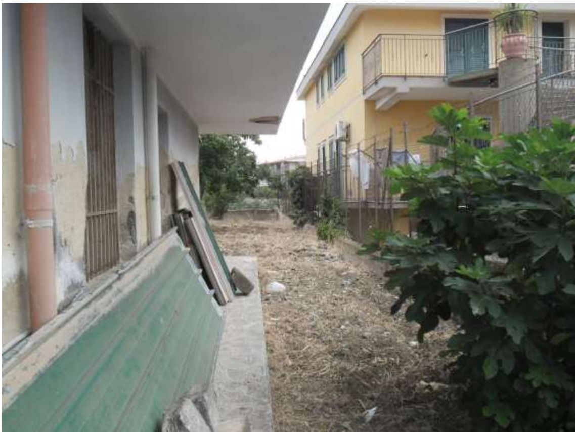
Figura 8 - Cortile lato Nord
