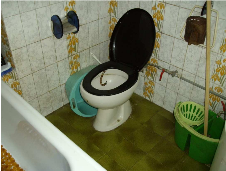
Particolare vista interna: lavanderia wc PS1
