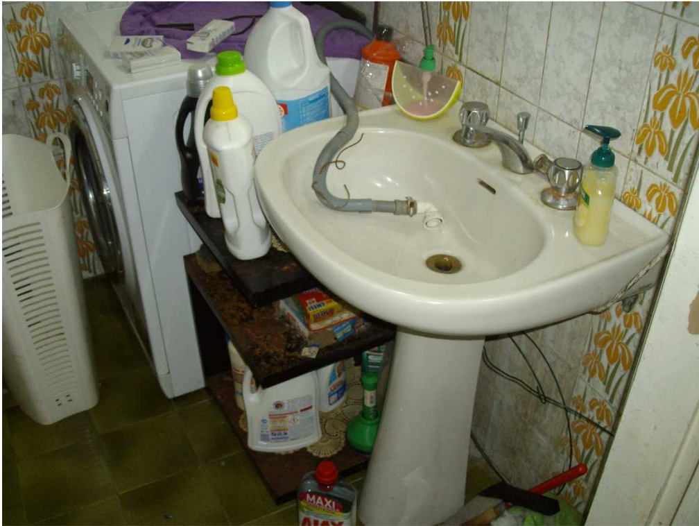
Particolare vista interna: lavanderia wc PS1
