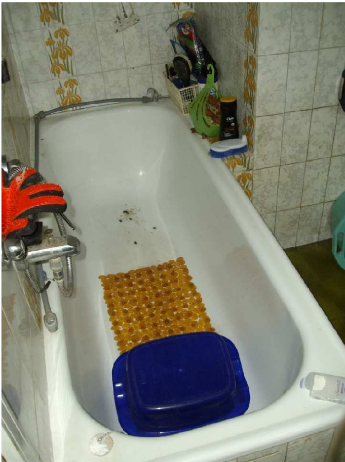
Particolare vista interna: lavanderia wc PS1
