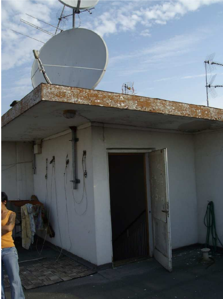
Particolare vista sbarco terrazzo
