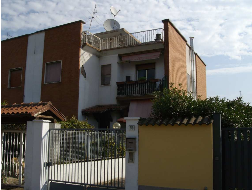
particolare vista esterna fronte strada
