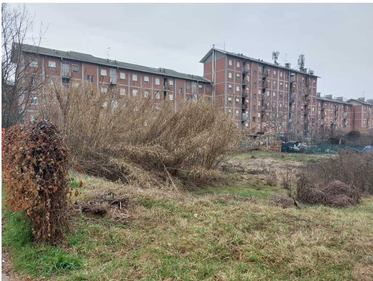
FOTO 4 – Foto da via Galimberti delle particelle 581-817-818 “ LOTTO 3 ”
