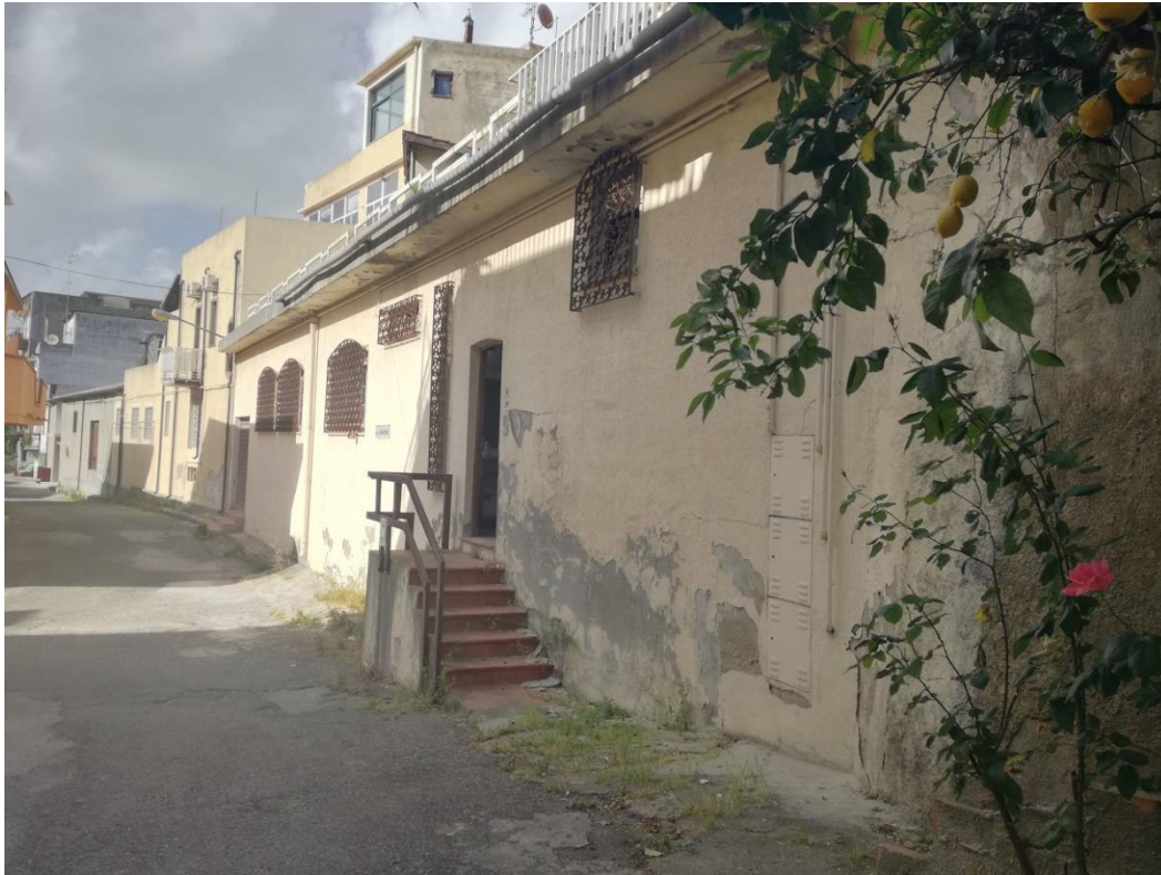
Foto 11: particella 7 sub 7 – via Generale Cadorna. Corpo di fabbrica seminterrato, utilizzato come pertinenza del sub 5.
