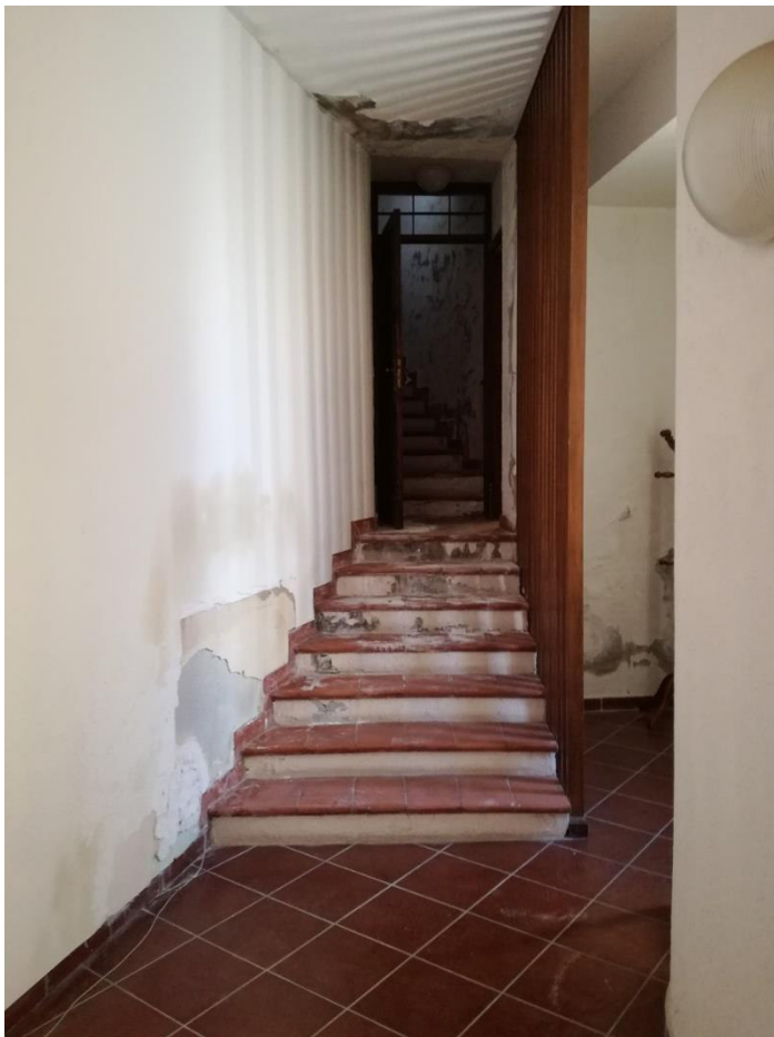
Foto 14: particella 7 sub 7 – scala interna di collegamento con il corpo di fabbrica principale.
