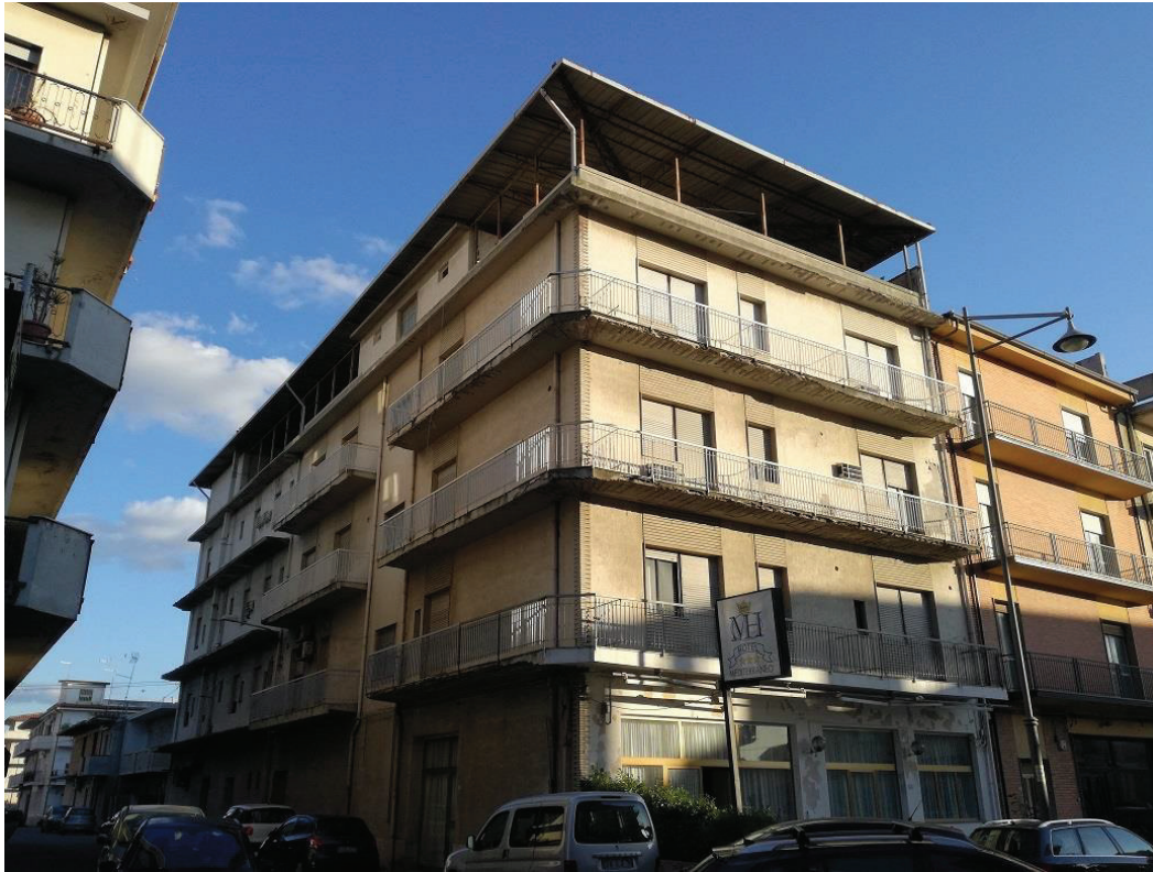
Foto 1: Catasto Fabbricati di Gioia Tauro, foglio 34, particella 136 – albergo a quattro piani f.t., parziale seminterrato e terrazza coperta da tettoia (lato nord-ovest confinante con la strada statale 18).
