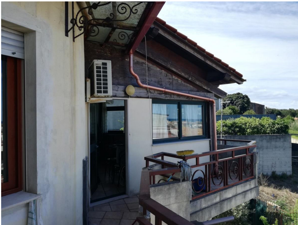
Foto 4: particella 7 sub 5 – appartamento al primo piano. Esterno lato nord.
