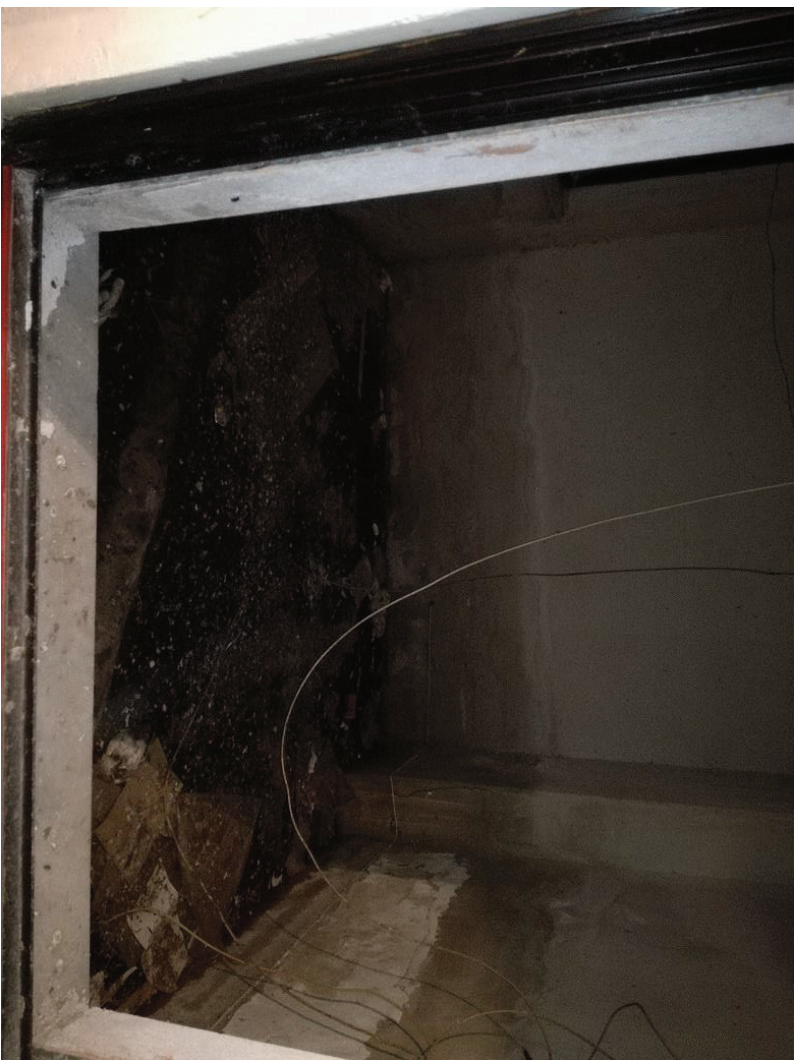
Foto 12: primo piano – pozzo luce.
