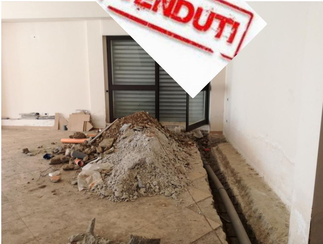
Foto 4: piano terra – dettaglio dello scavo.
