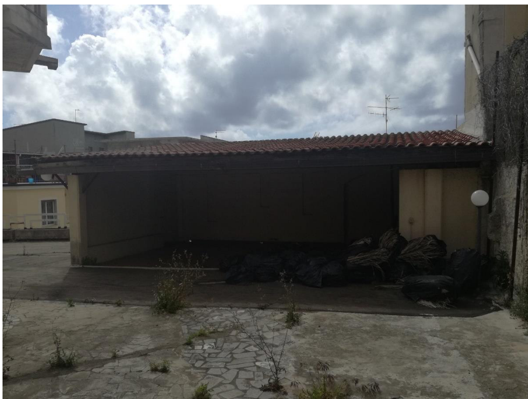
Foto 12: particella 7 sub 2 – corte comune. Il corpo di fabbrica "B", chiuso su tre lati, copre una superficie lorda di circa 46,00 m 2 .
