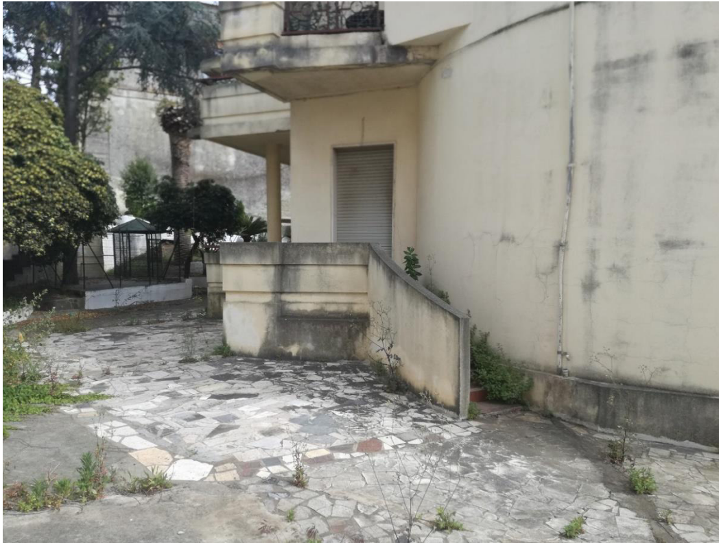
Foto 3: particella 7 sub 4 – appartamento al piano terra. Accesso alla corte comune.
