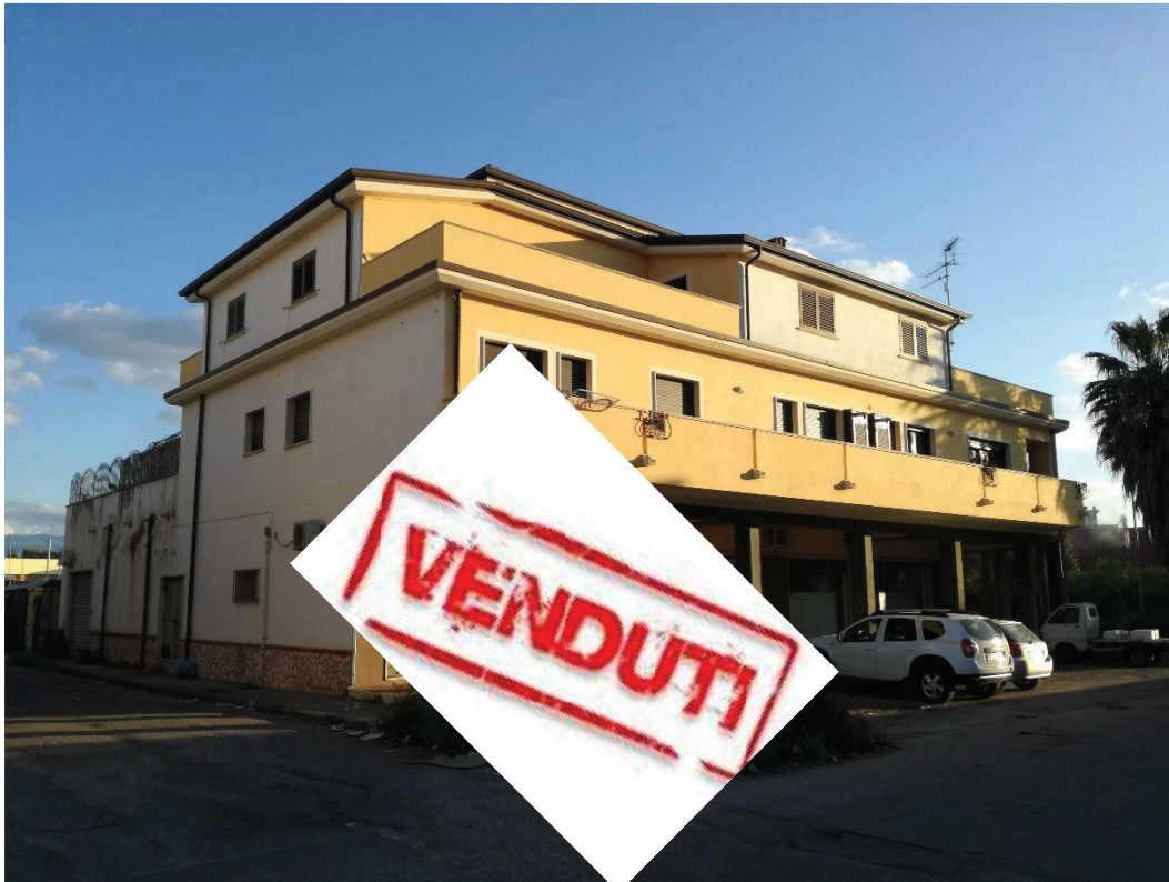
Foto 1: Catasto Fabbricati di Gioia Tauro, foglio 34, particella 953 – fabbricato a tre piani f.t. oltre piano interrato.
