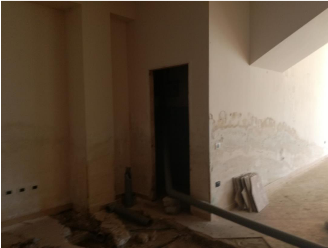
Foto 5: piano terra – vano w.c. realizzato in un sottoscala.
