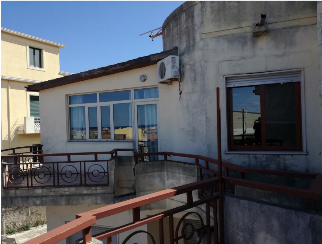
Foto 3: particella 7 sub 5 – appartamento al primo piano. Esterno lato sud.
