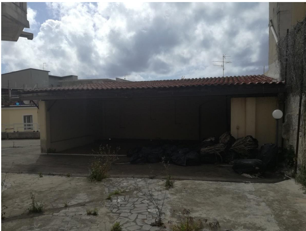
Foto 18: particella 7 sub 2 – corte comune. Il corpo di fabbrica "B", chiuso su tre lati, copre una superficie lorda di circa 46,00 m 2 .
