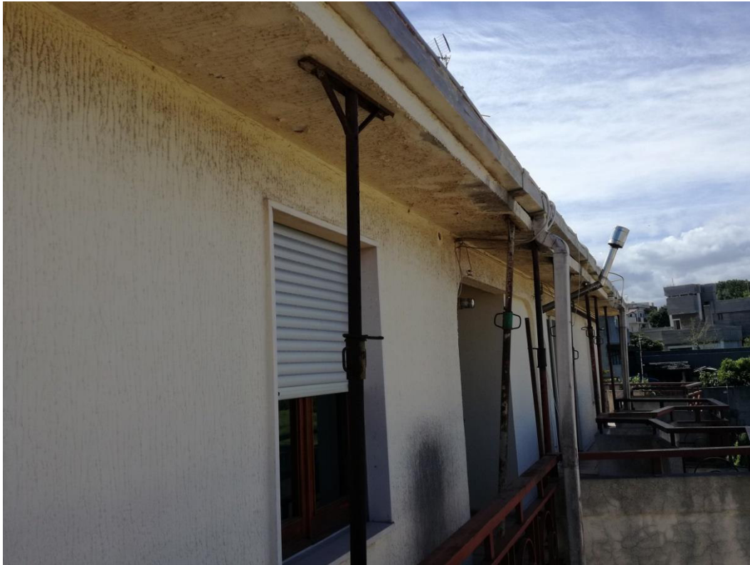
Foto 7: particella 7 sub 5 – esterno lato ovest.
