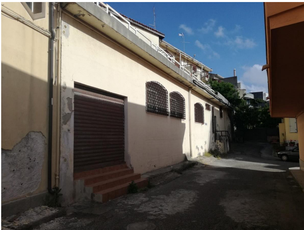
Foto 12: particella 7 sub 7 – via Generale Cadorna.
