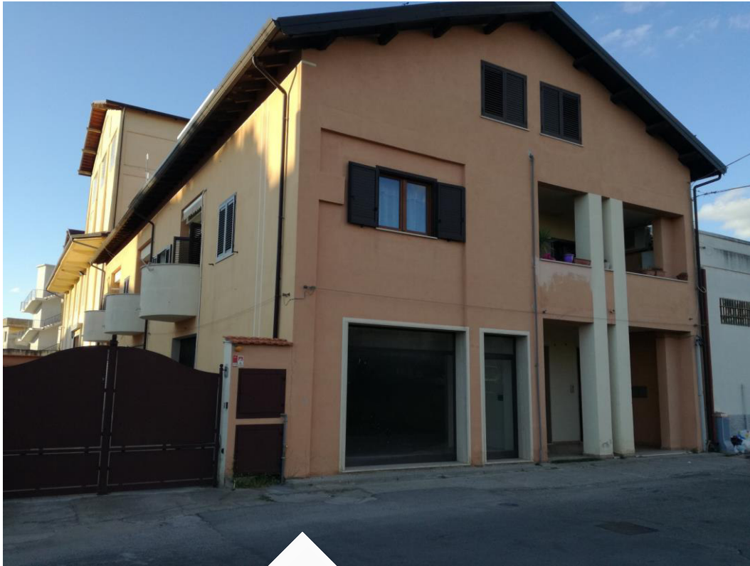
Foto 1: Catasto Fabbricati di Gioia Tauro, foglio 34, particella 966 – fabbricato a tre piani f.t.
