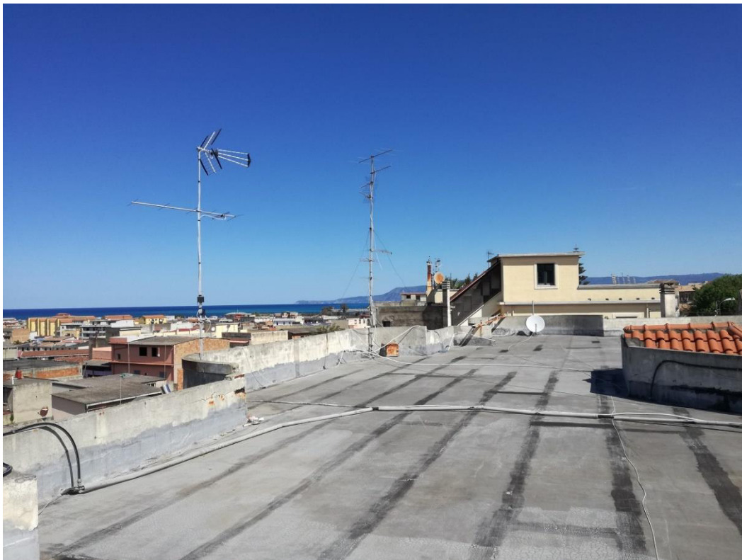
Foto 10: particella 7 sub 6 – terrazza.
