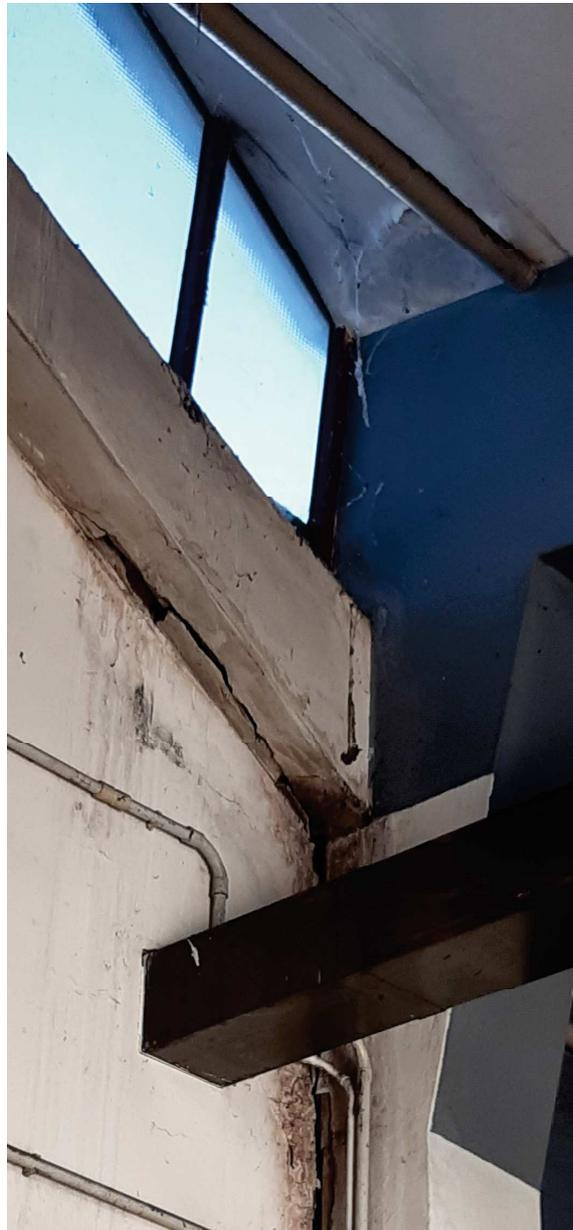
*Particolare delle infiltrazioni meteoriche dai serramenti delle volte*
