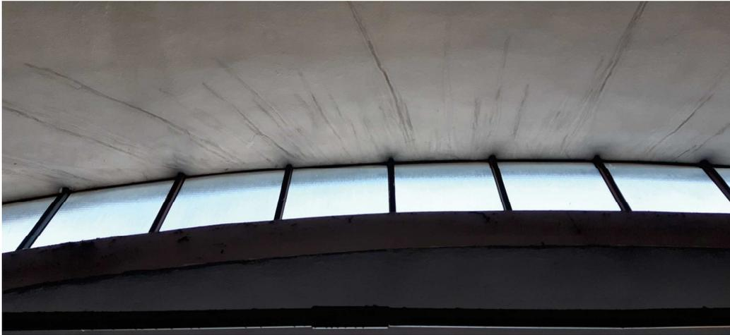
*Particolare delle infiltrazioni meteoriche dai serramenti delle volte*
