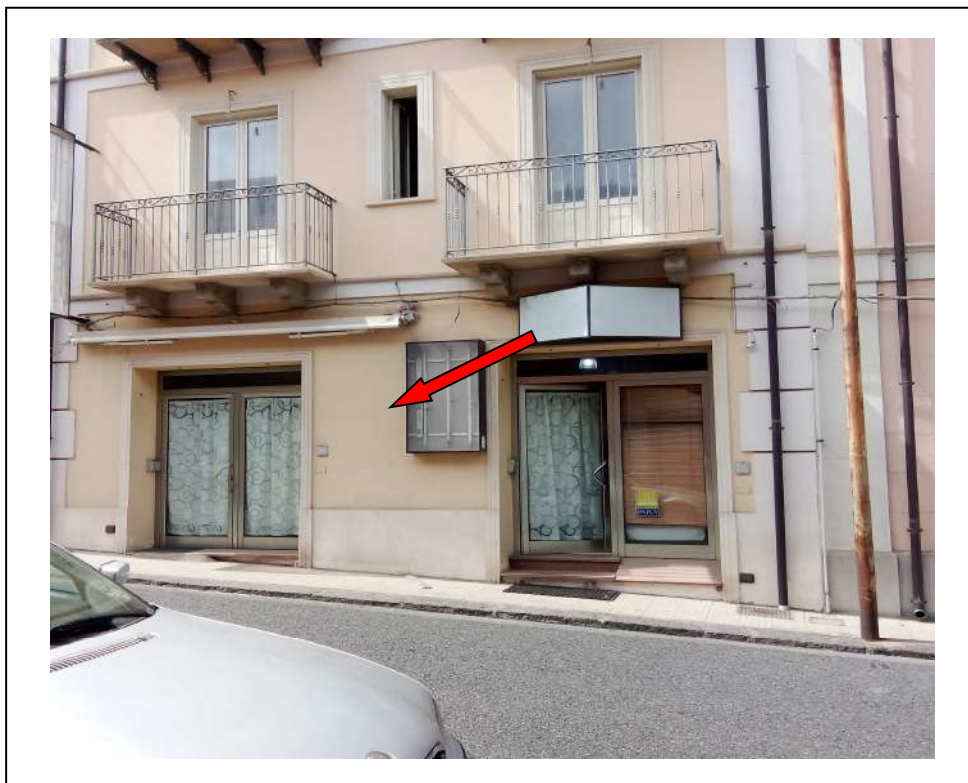
FOTO n° 13 : Inquadratura fotografica del prospetto dell'unità immobiliare, oggetto di stima, prospiciente su via Cesare Battisti piano primo sottostrada.
