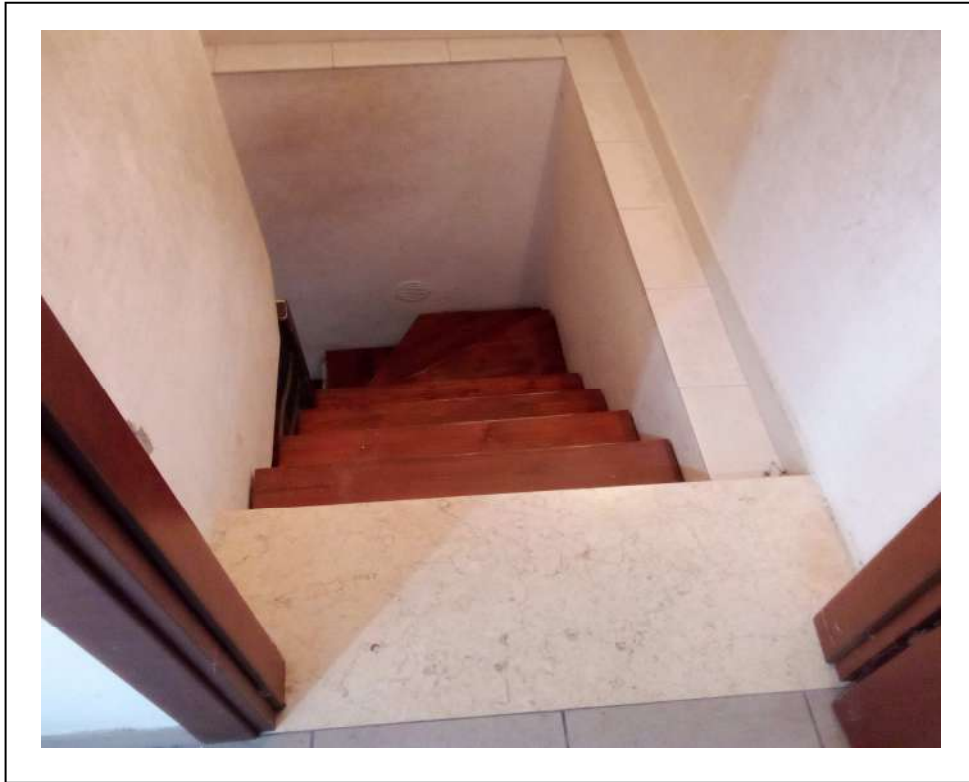
FOTO n° 11 : Scorcio fotografico dell'arrivo vano [redacted] dal quale si intravede la scala in ferro di collegamento con l'unità immobiliare (sub 8)
