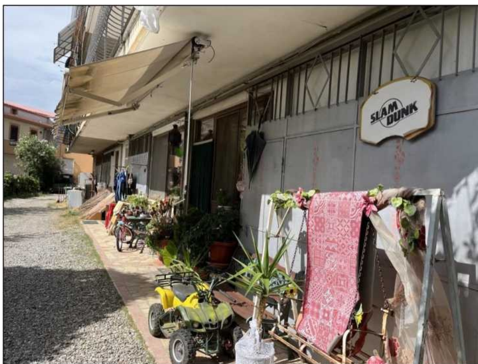
Fig. 8 - FOTO FABBRICATO lato posteriore - BENI SITI IN COMUNE DI ZAGARISE (INGRESSO UNITA' IMMOBILIARE PIANO TERRA SUB 3)
