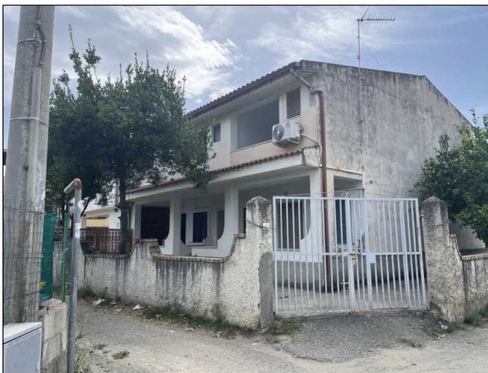
Fig. 14 — Vista esterno fabbricato
