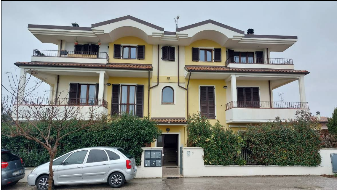
Immagine 04 –Vista del fronte da Str. Delle Caminate.
