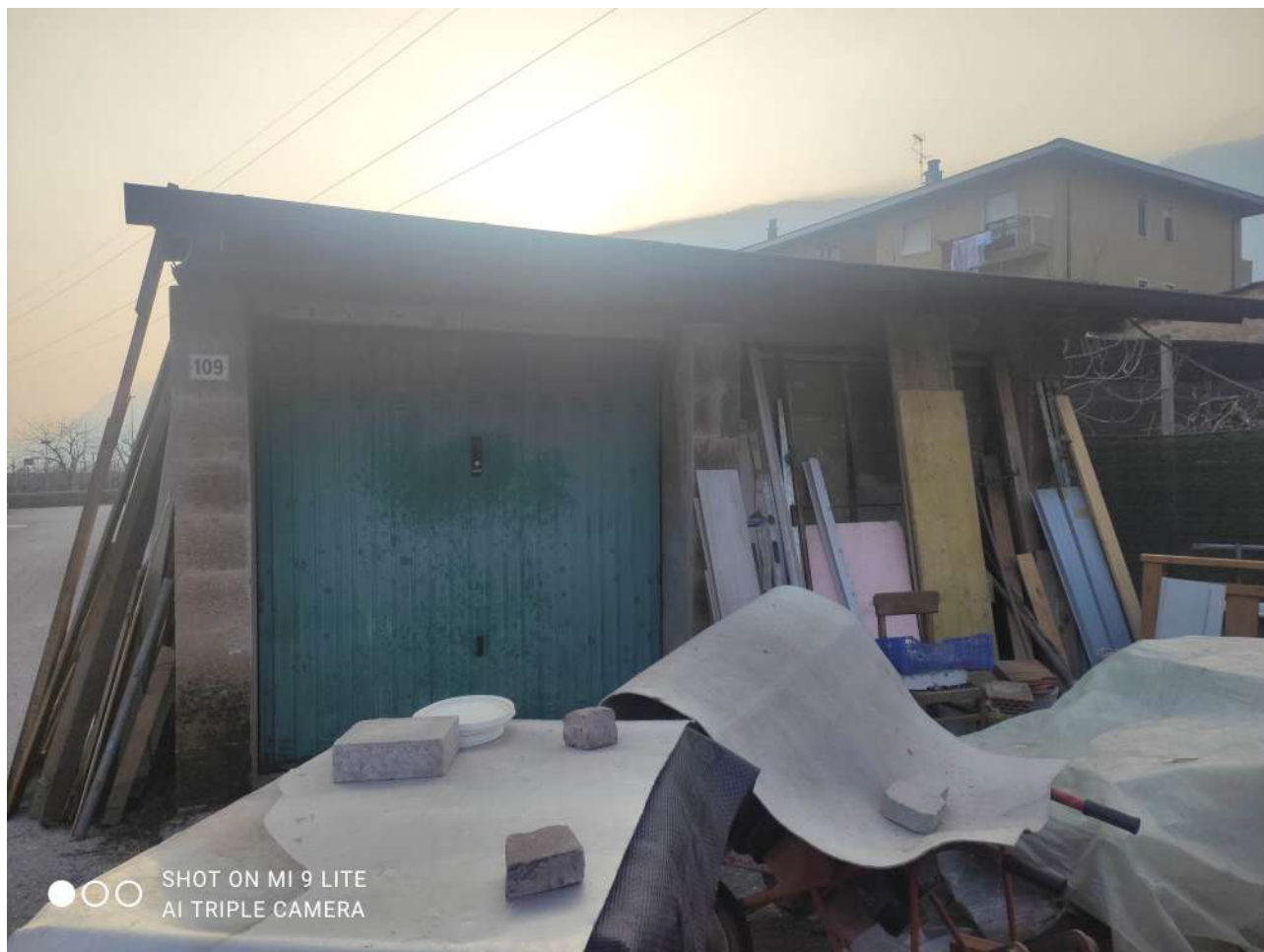
Figura 9: C.C. VILLALAGARINA P.ED. 410 (facciata nord).
