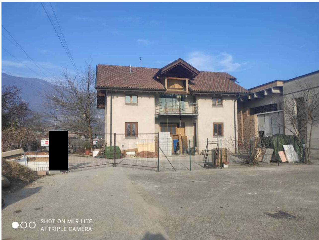
Figura 16: C.C. VILLA LAGARINA P.ED. 469 (FACCIATA SUD).
