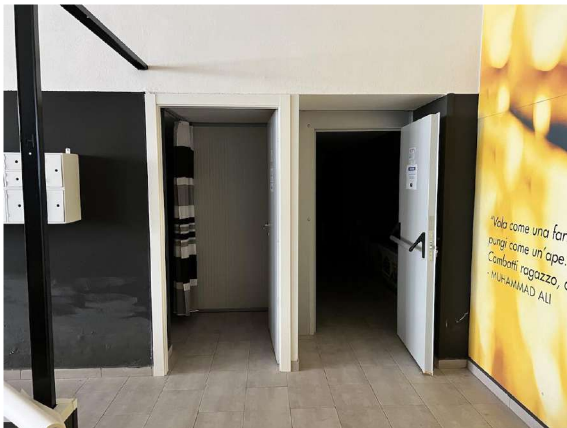
Pag. 05 – FOTO 06: Vista della porta di accesso allo spogliatoio donne (a sinistra) e di quella del tipo antipanico, di accesso al vano vuoto (a destra).
