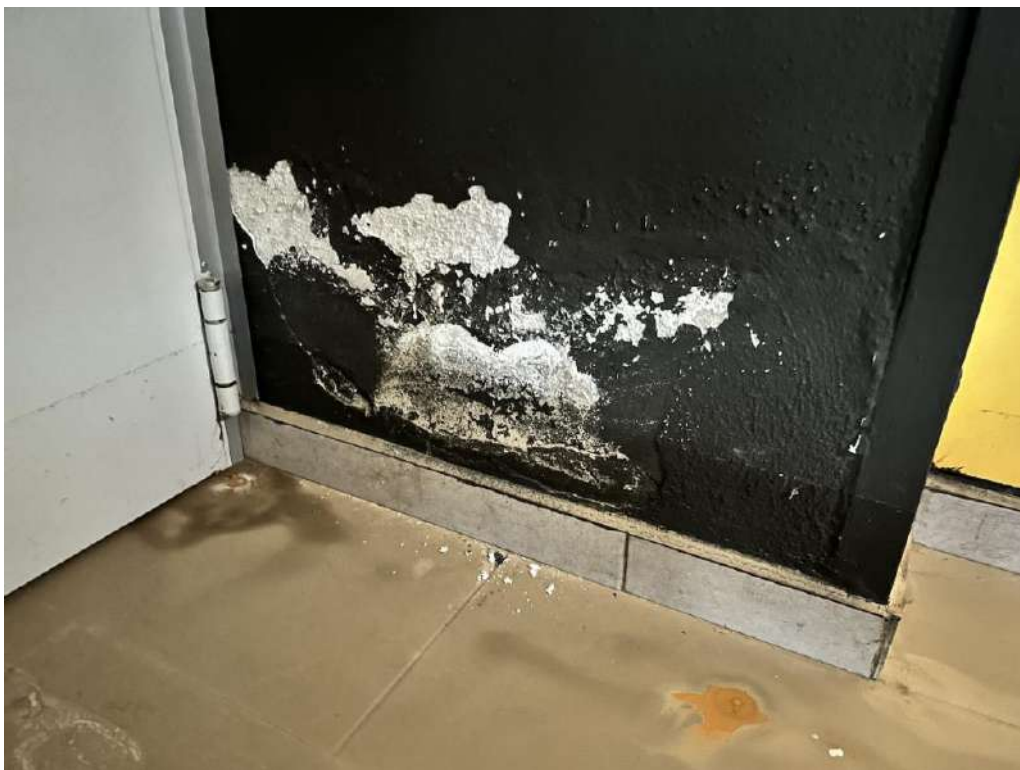
FOTO 29: Particolare di un altro dei pilastri del piano cantinato sottoposto all'umidità di risalita ed al fango creatosi in seguito al nubifragio-alluvione del 3 dicembre 2022.
