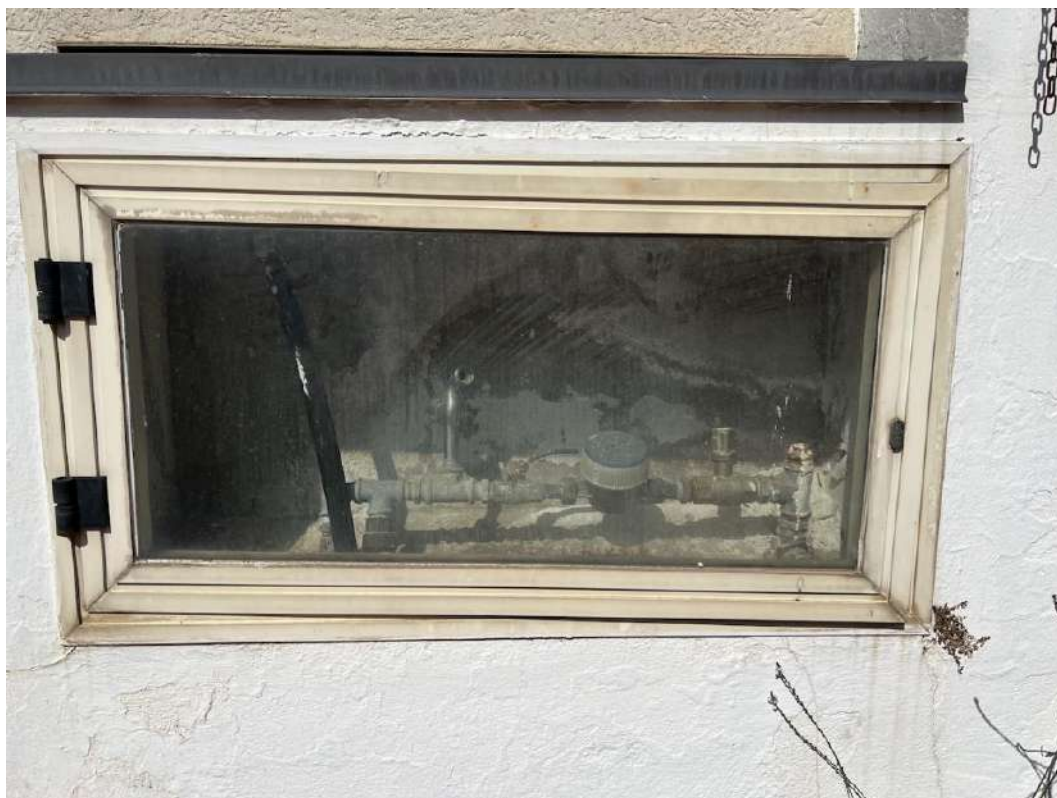
FOTO 03 : Seconda nicchia solo per il contatore acqua (FUNZIONANTE).
