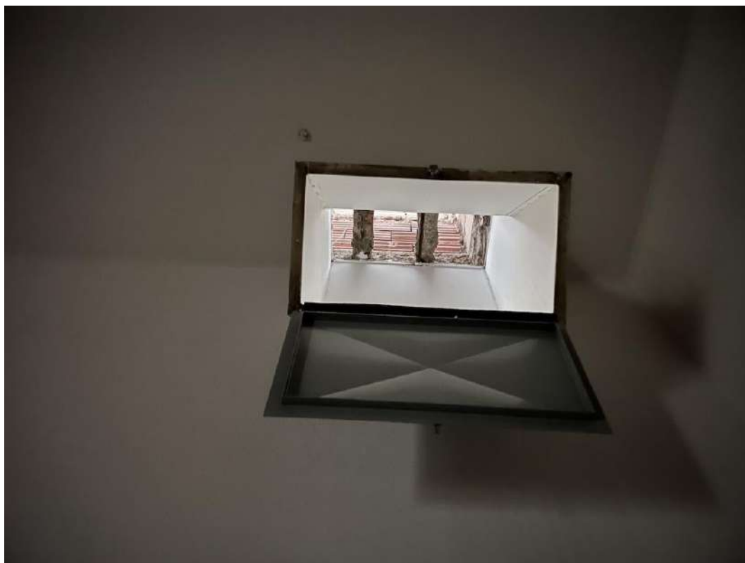
FOTO 12 : Particolare del bocchettone d'aria nel vano vuoto, a piano cantinato.
