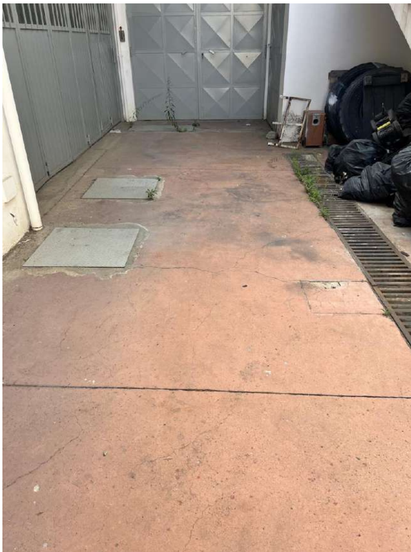
Pag. 08 – FOTO 10: vista dell'apertura per l'ingresso al vano adiacente al piano cantinato e della caditoia che attraversa il cortile.
