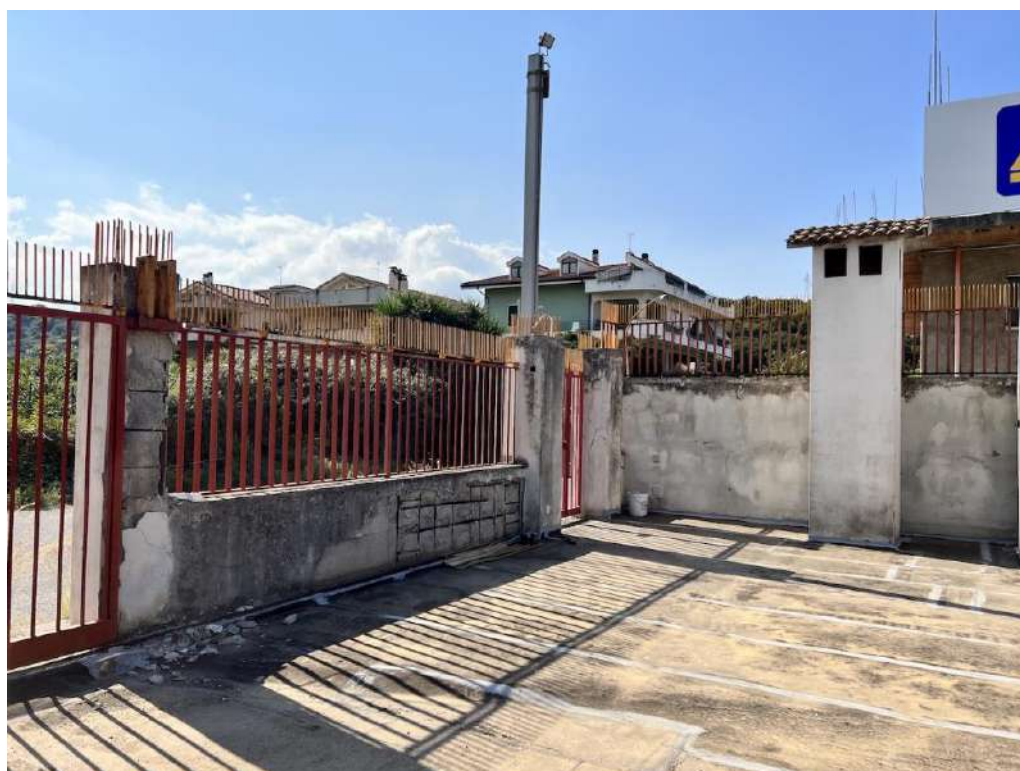
FOTO 18: Vista dei muretti in c.a. con ringhiera in ferro sulla parte superiore, sul lato sud dell'area esterna dell'immobile.
