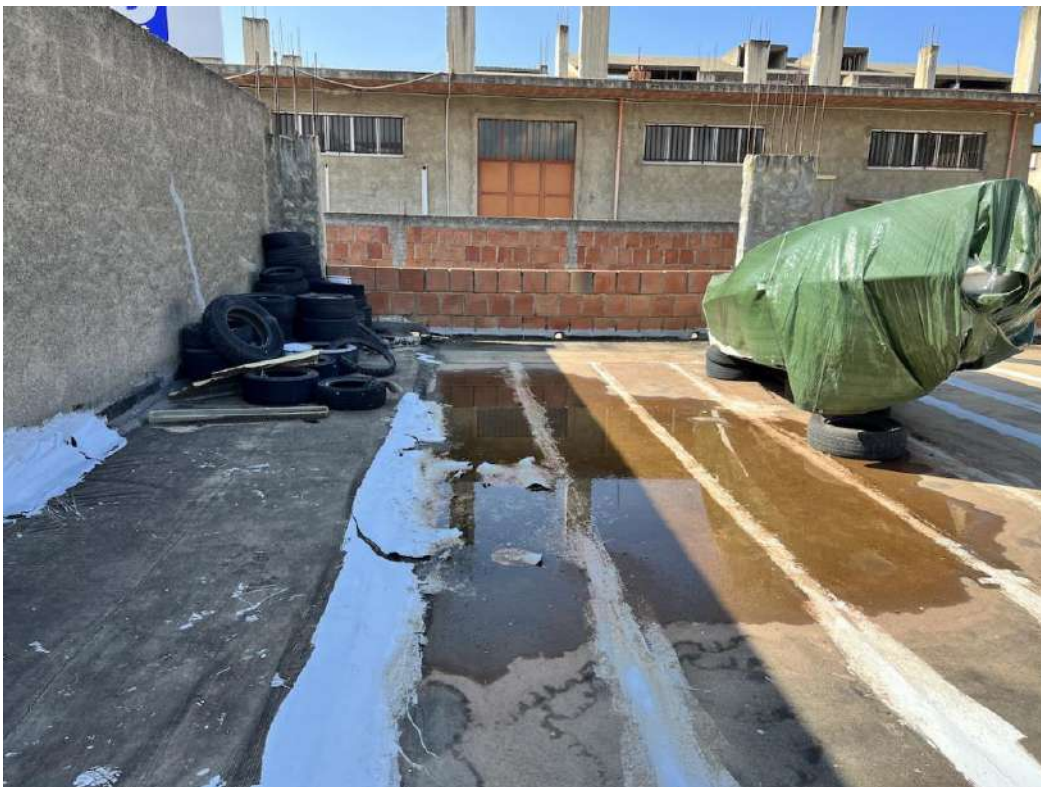
FOTO 26: Particolare della guaina al piano terra (area esterna), sulla parte posteriore del magazzino, in condizioni pessime e priva di pendenze (con acqua stagnante per lunghi periodi).
