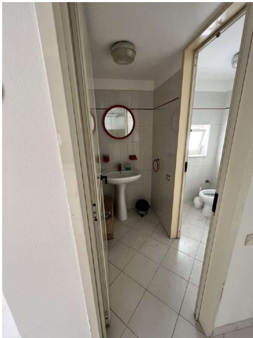
Pag. 06 – FOTO 07 : Vista del bagno e dell'antibagno a piano ammezzato.
