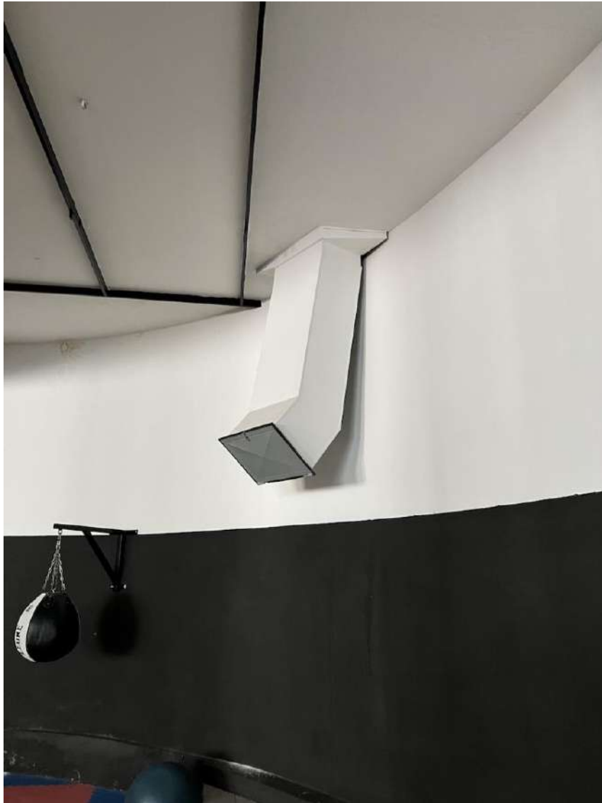
Pag. 13 – FOTO 17: Vista del secondo bocchettone d'aria, situato nella zona nord-est del piano cantinato, in vicinanza del muro curvilineo.
