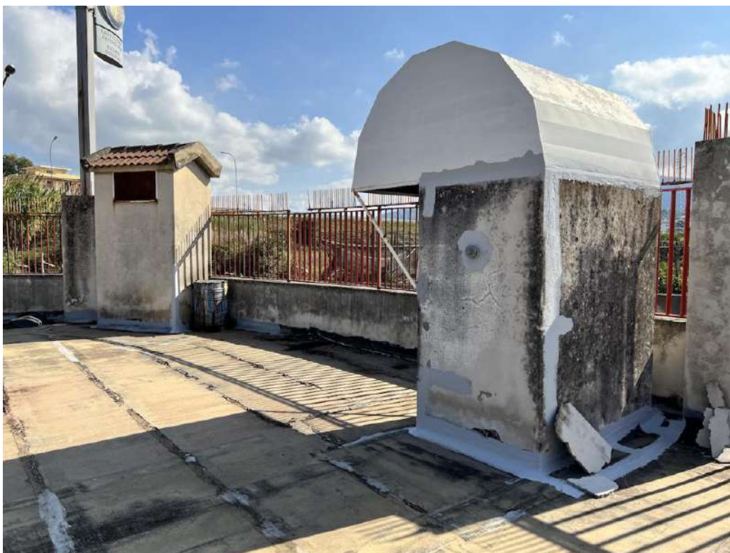
FOTO 28: Vista di alcuni bocchettoni di areazione (corrispondenti all'originaria area di verniciatura a p.c.), nell'area esterna vicino al cancello carrabile lato via Cav. Luigi Stilo
