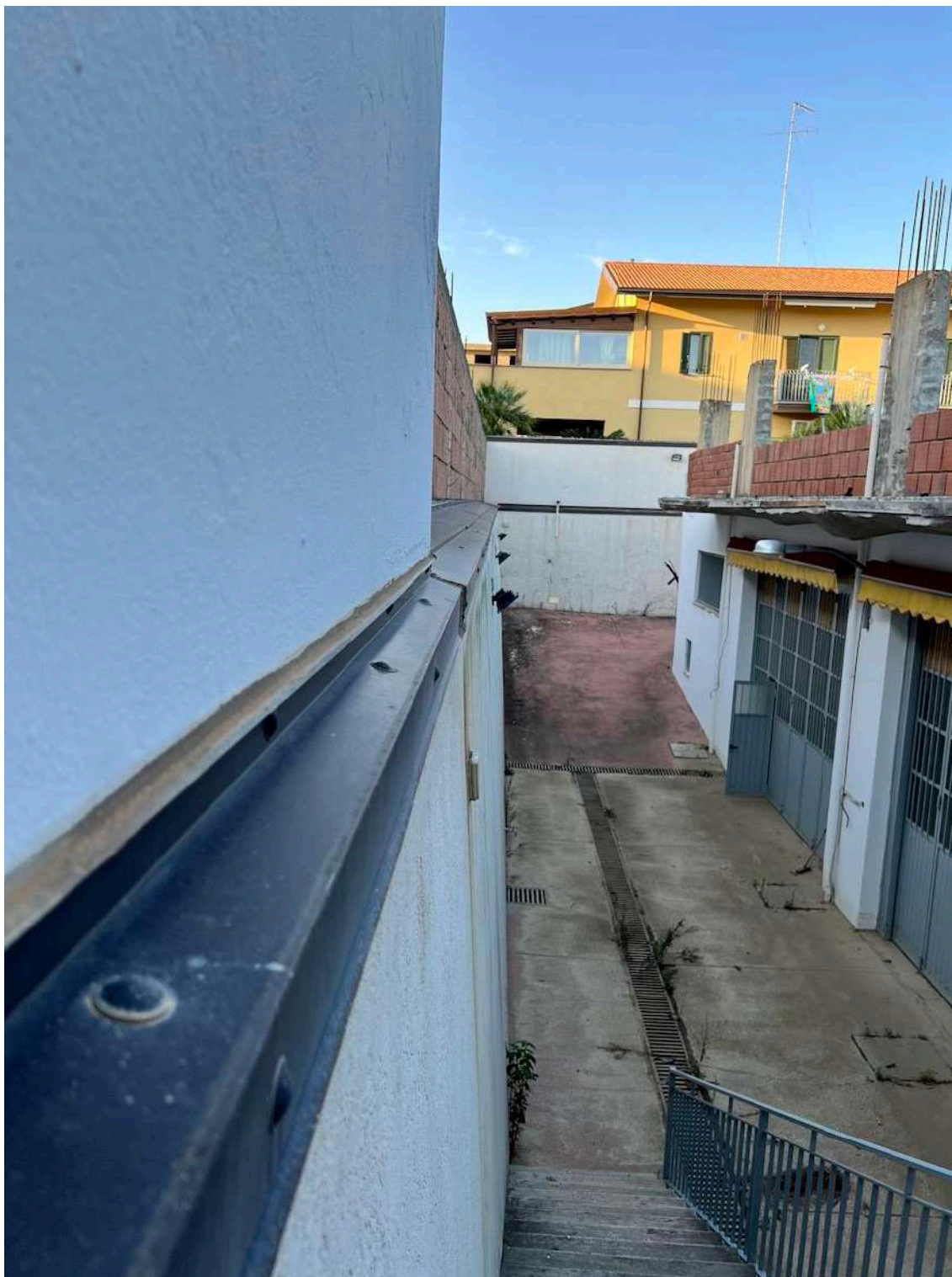
Pag. 15 – FOTO 19: Particolare della scossalina tra il muro perimetrale ed il materiale fonoassorbente, e vista del cortile del piano cantinato.
