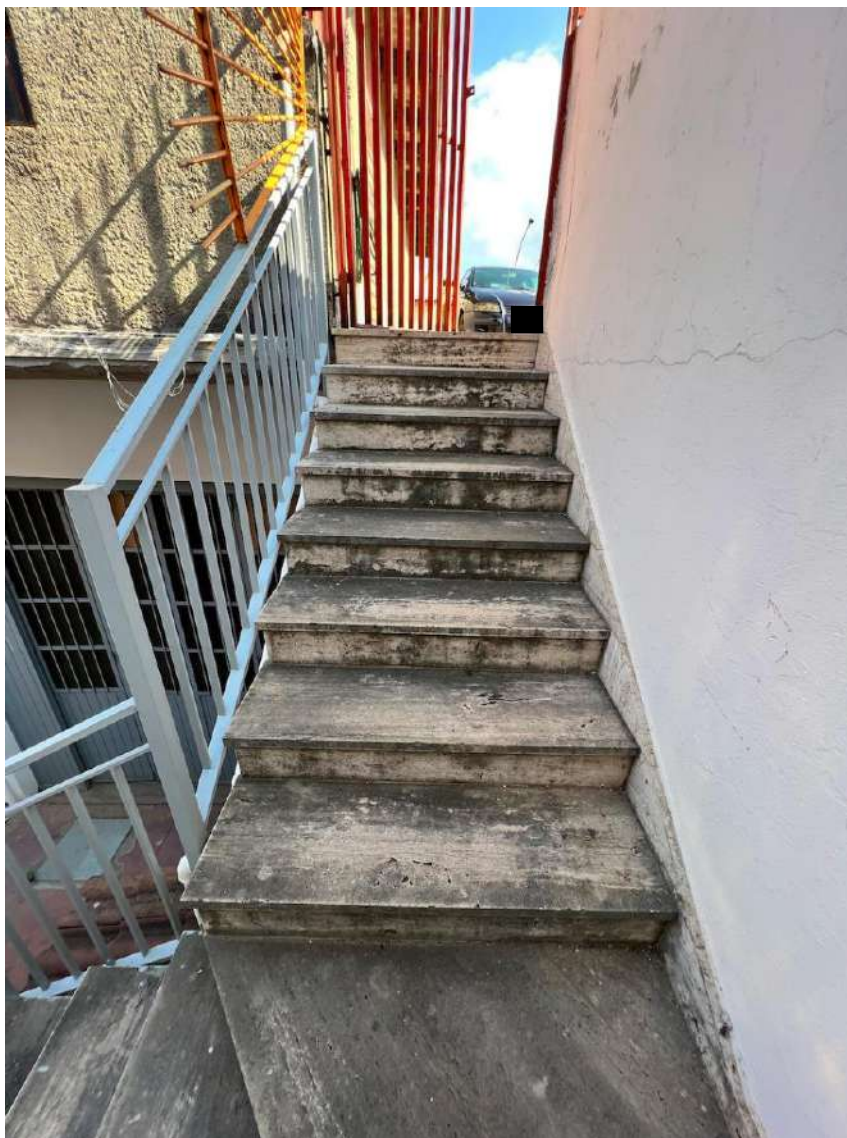
Pag. 12 – FOTO 14: Seconda rampa della scala esterna che, dal cortile a piano cantinato, conduce al piano terra.
