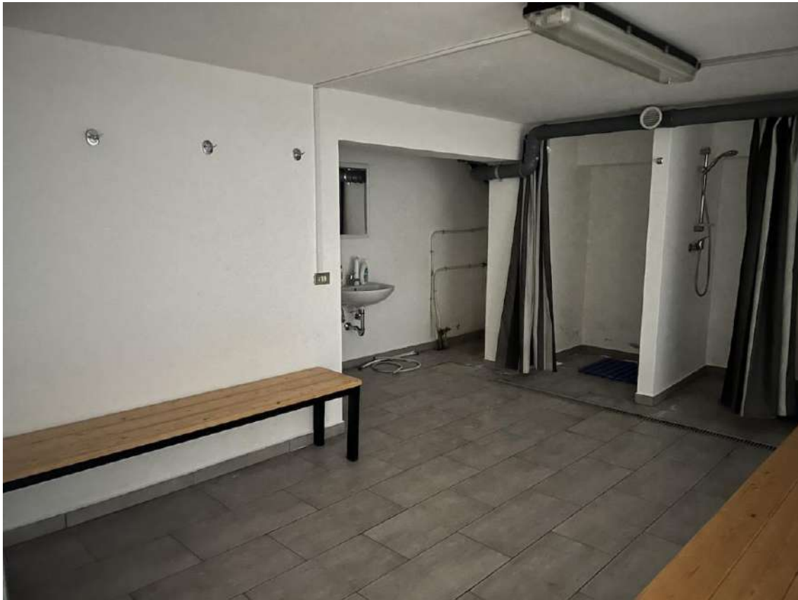
Pag. 03 – FOTO 04: Vista dello spogliatoio uomini e delle docce con lo spazio ricavato per il lavabo dalla demolizione di un muro divisorie (vedasi Allegato D1 - RICOSTRUZIONE PIANTINA del piano cantinato).
