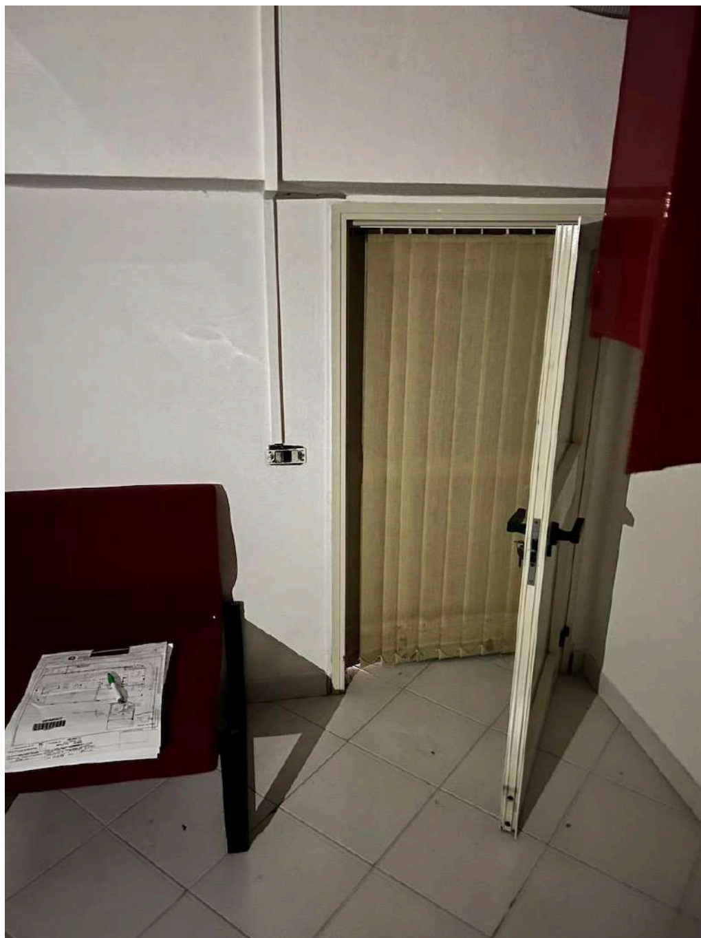
Pag. 11 – FOTO 14: Vista della piccola porta della stanza ripostiglio non comunicante con l'adiacente seconda stanza a piano ammezzato (destinata ad ufficio).
