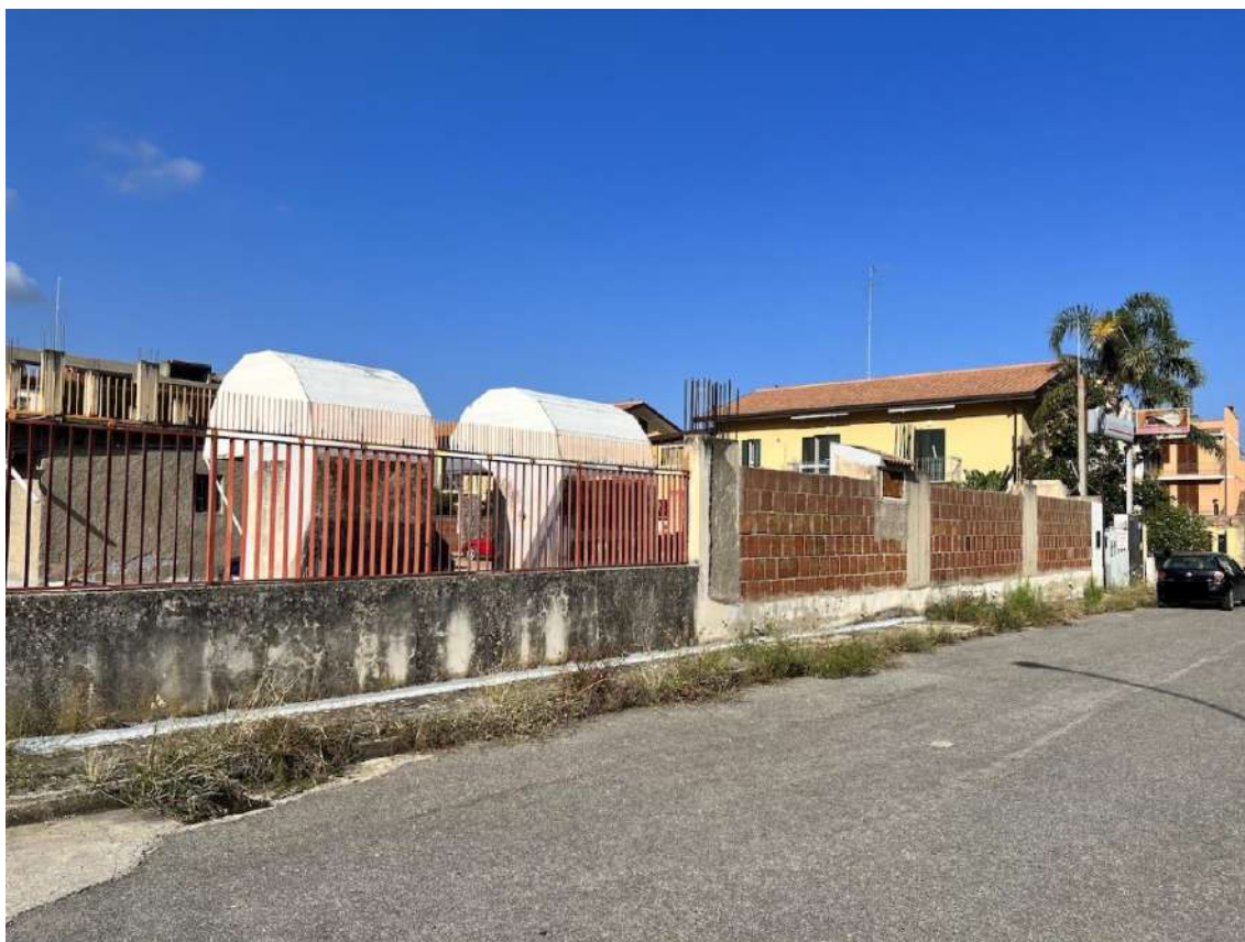
Pag. 07 – FOTO 08: Vista panoramica dei muri perimetrali dell'area esterna dell'immobile, a piano terra lato strada pubblica (via Cav. Luigi Stilo).
