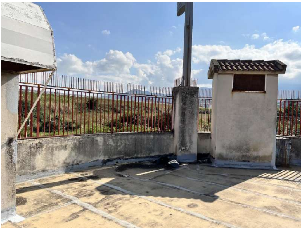
Pag. 19 – FOTO 27: Vista di alcuni bocchettoni di areazione (corrispondenti all'originaria area di verniciatura a piano cantinato), sulla zona curva dell'area esterna.
