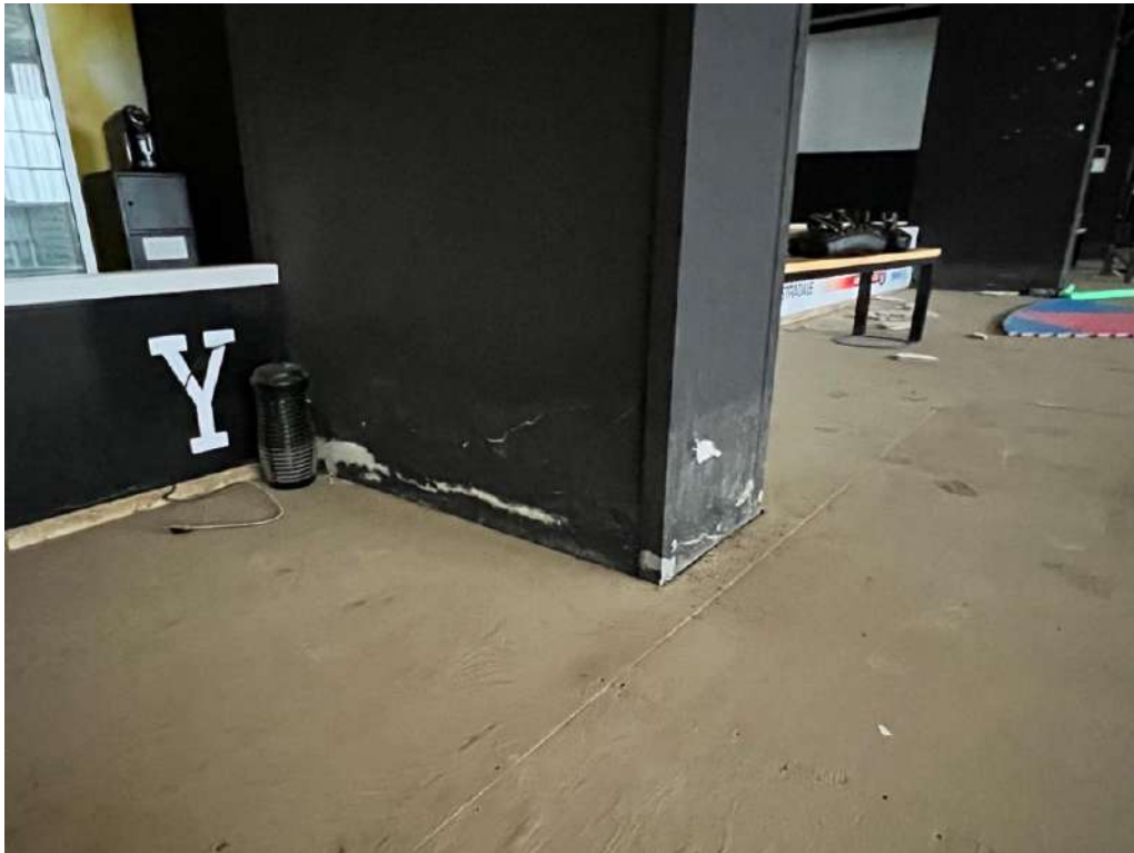
FOTO 29: Particolare di un altro dei pilastri del piano cantinato sottoposto all'umidità di risalita ed al fango creatosi in seguito al nubifragio-alluvione del 3 dicembre 2022.
