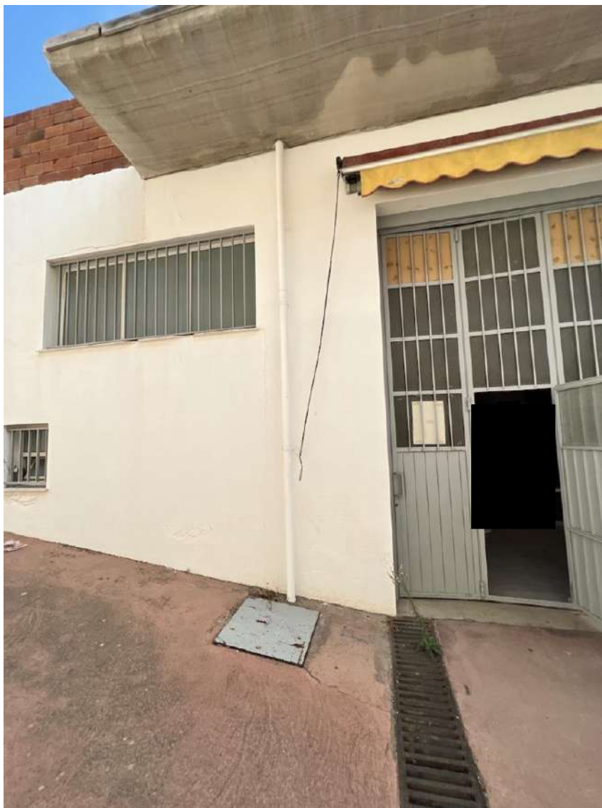
Pag. 05 – FOTO 07: Vista della prima apertura a piano cantinato, con la porta di ingresso pedonale che conduce all'interno del fabbricato.
