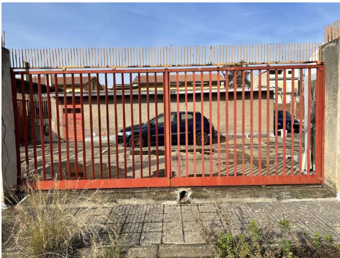
Pag. 04 – FOTO 04: Vista del cancello grande per l'ingresso carrabile nell'area esterna dell'immobile, dal n.c. 49 di via Cav. Luigi Stilo.
