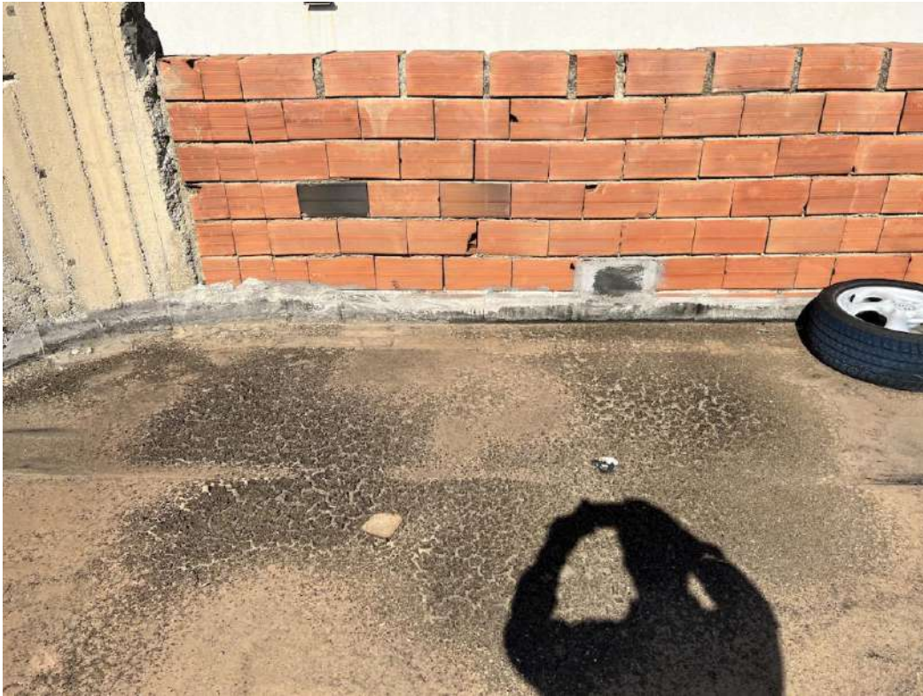
FOTO 26: Particolare della guaina al piano terra (area esterna), sulla parte posteriore del magazzino, in condizioni pessime e priva di pendenze (con acqua stagnante per lunghi periodi).
