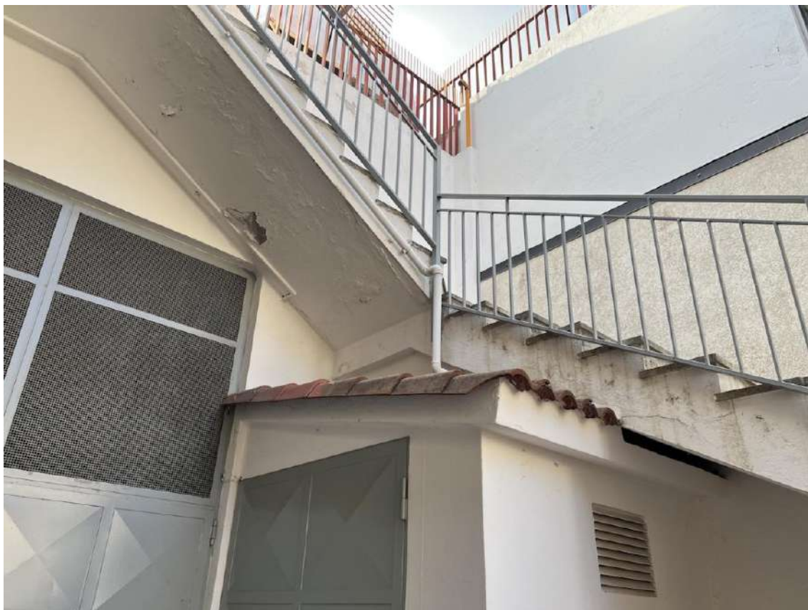
Pag. 11 – FOTO 13: Vista della soletta della rampa scala esterna e del piccolo vano tecnico sottoscala (abusivo).
