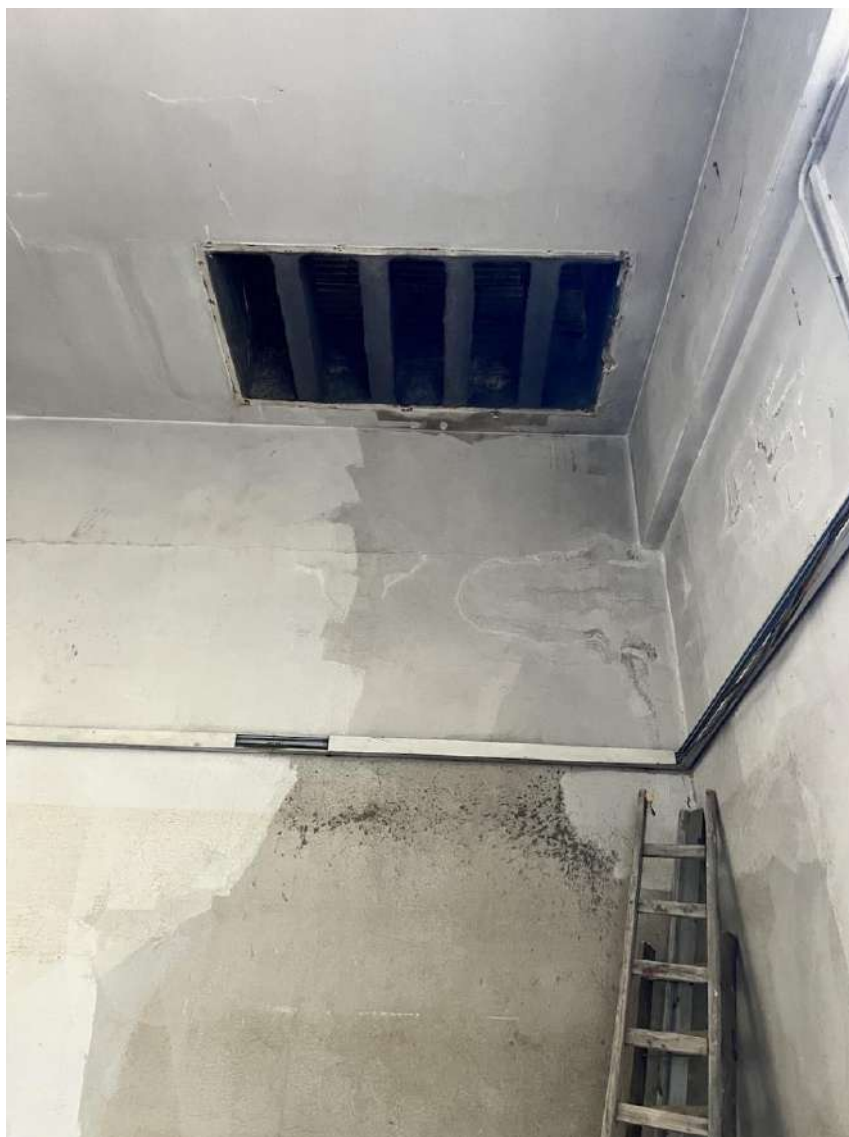
Pag. 18 – FOTO 25: VANO ADIACENTE A PIANO CANTINATO: Bocchettone per aspirazione aria in questo vano, lato parete esterna (Interrata).
