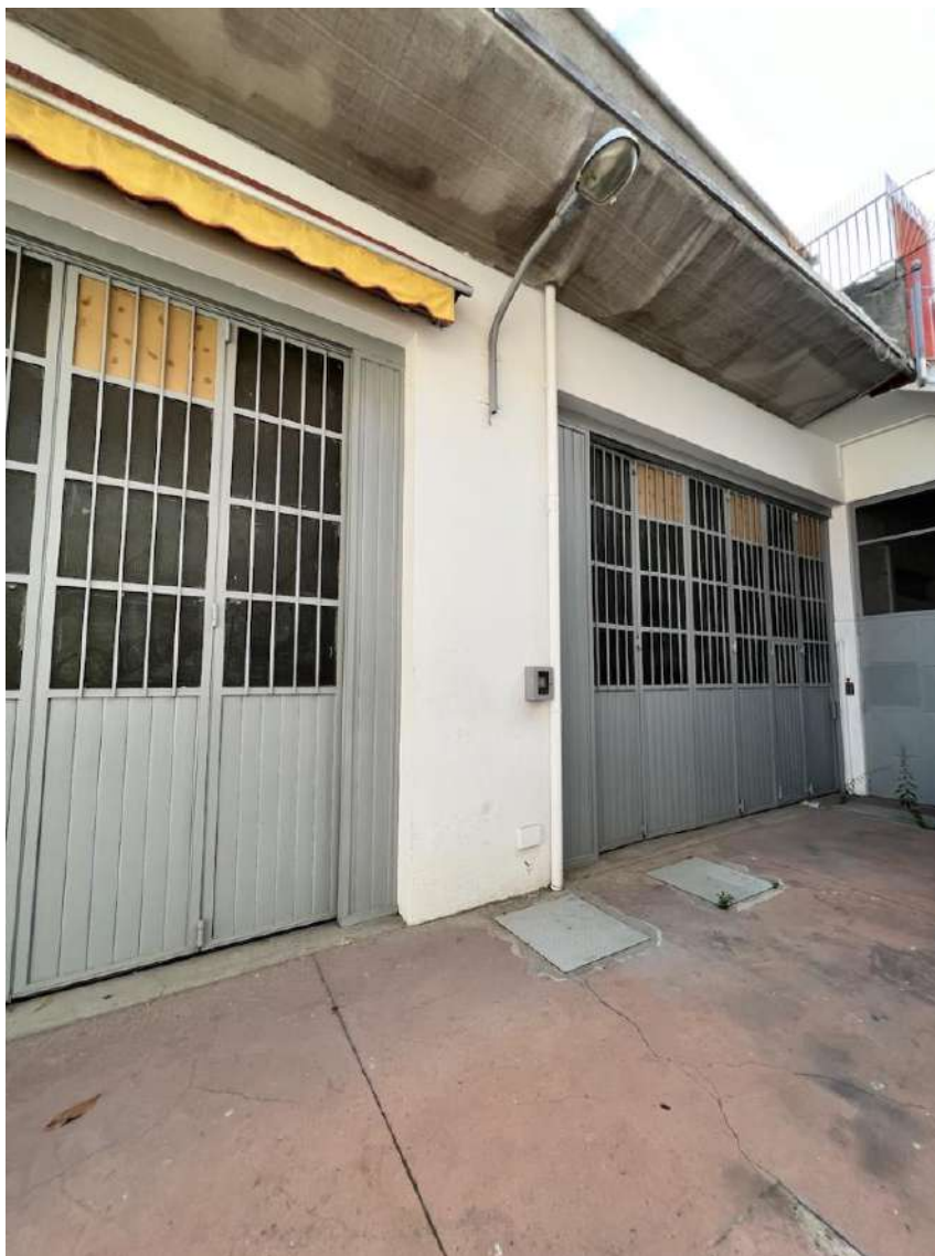
Pag. 07 – FOTO 09: Altra vista della grandi aperture al piano cantinato e dei due pozzetti corrispondenti alle pompe di sollevamento.
