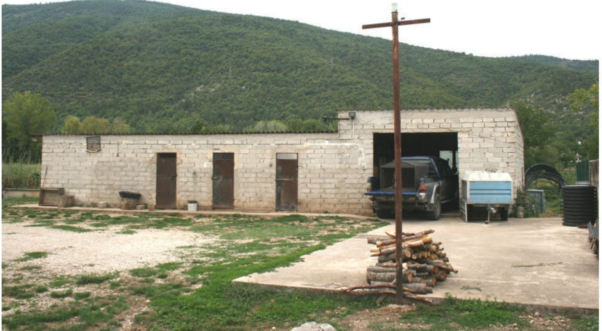
Fronte principale magazzino indipendente
