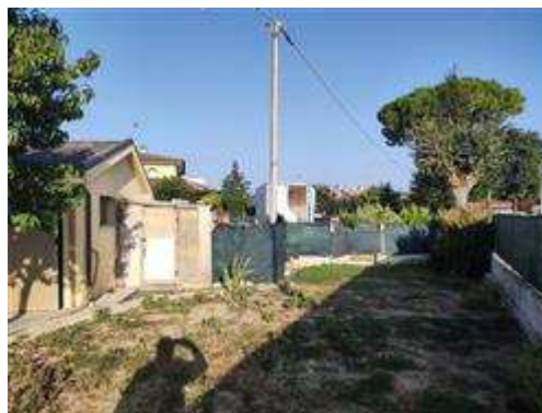
Rimozione capanni in legno
