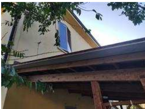
Rimozione copertura pergola
