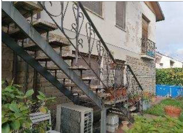
foto n.15 – prospetto laterale dx del resede giardino
