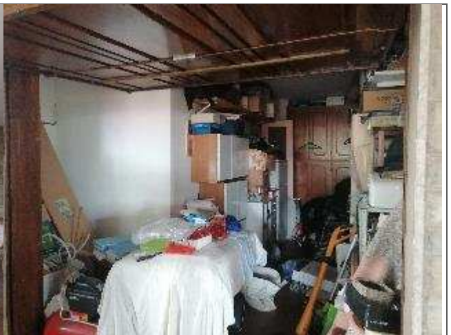
foto n.14 – autorimessa al p.t. (loc.n.17)
