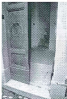
Foto 05 - Uscio con gradino
