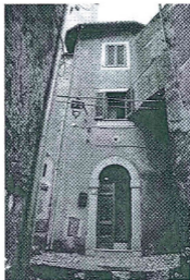
Foto 01 - L'ala immobiliare cielo-terra Via Crognaleto, 86
