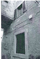
Foto 04 - Vista finestre P.T. e P.P.
