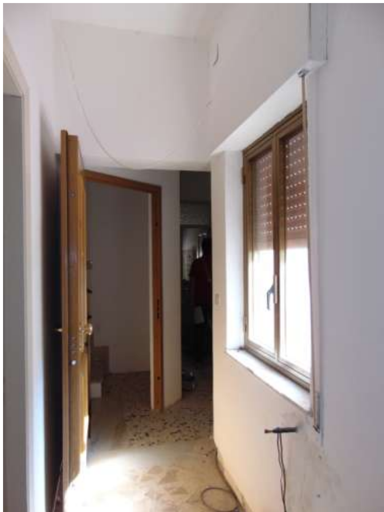
FOTO 01 - APPARTAMENTO 1° PIANO (LOTTO 2) ingresso e corridoio
