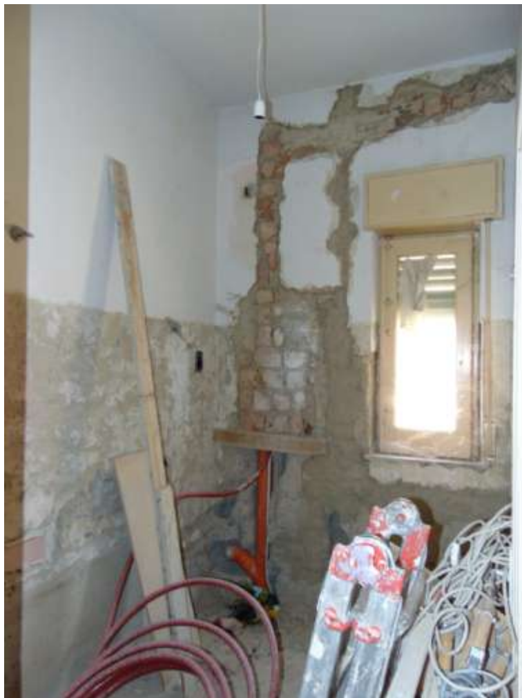
FOTO 05 - APPARTAMENTO 1° PIANO (LOTTO 2) servizio igienico
