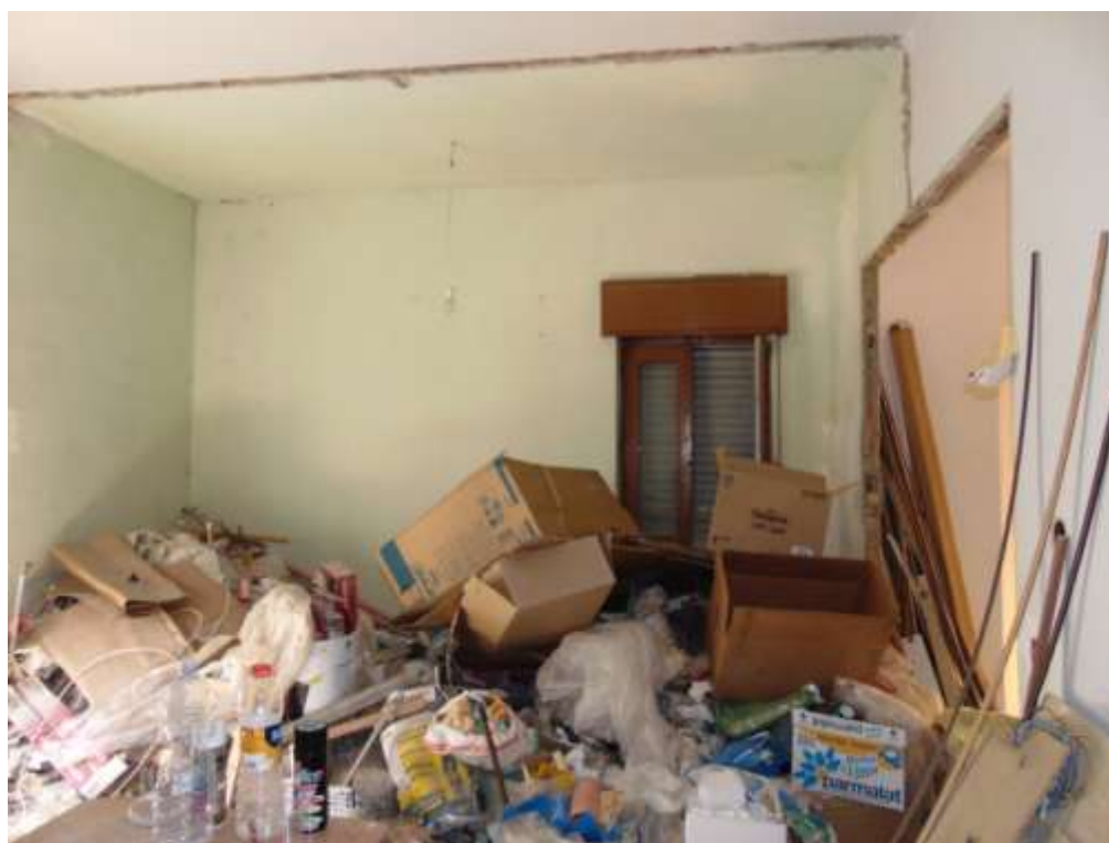
FOTO 02 - APPARTAMENTO 1° PIANO (LOTTO 2) soggiorno
