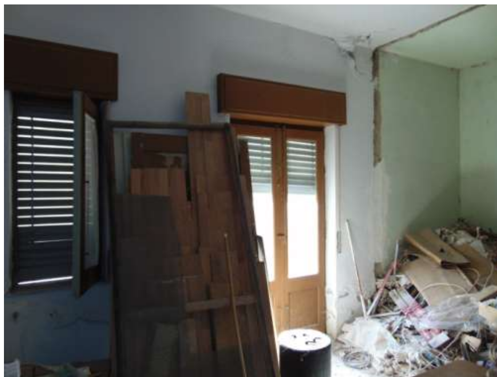
FOTO 04 - APPARTAMENTO 1° PIANO (LOTTO 2) soggiorno
