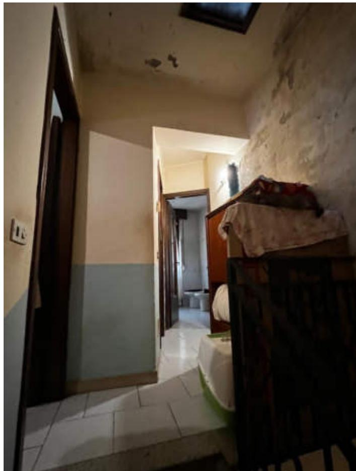
Il disimpegno del piano primo (si notano le infiltrazioni dal tetto)
