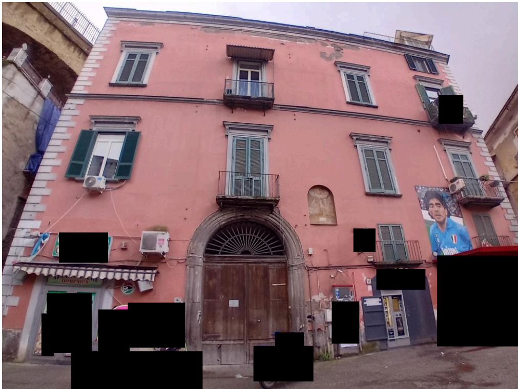
FOTO 4 – la facciata del fabbricato di via Sanità 55, in alto a destra la finestra dell'immobile in esame
