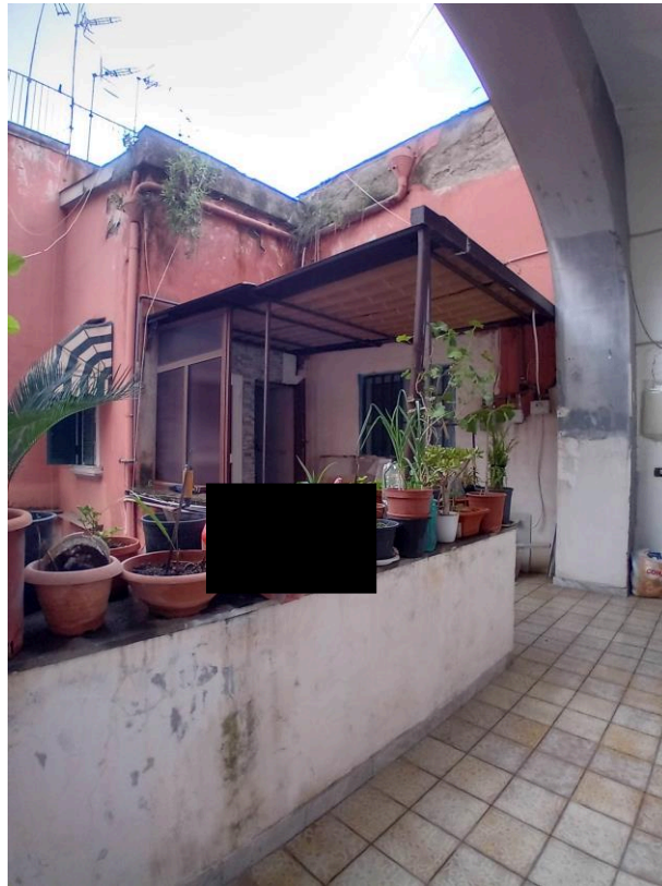
FOTO 9 – pianerottolo del secondo piano
