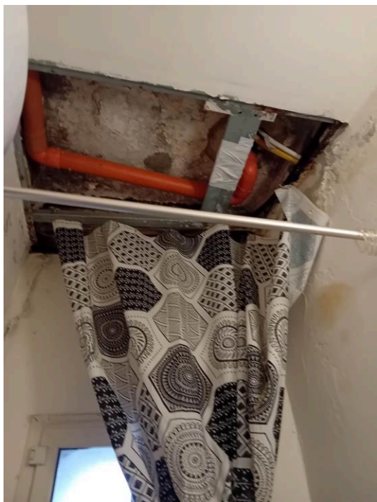
FOTO 29-30 – Il bagno: dettagli di infiltrazioni d’acqua e di umidità diffusa: dalla controsoffittatura (parzialmente demolita) e sulla muratura del fabbricato prospiciente Discesa Sanità
