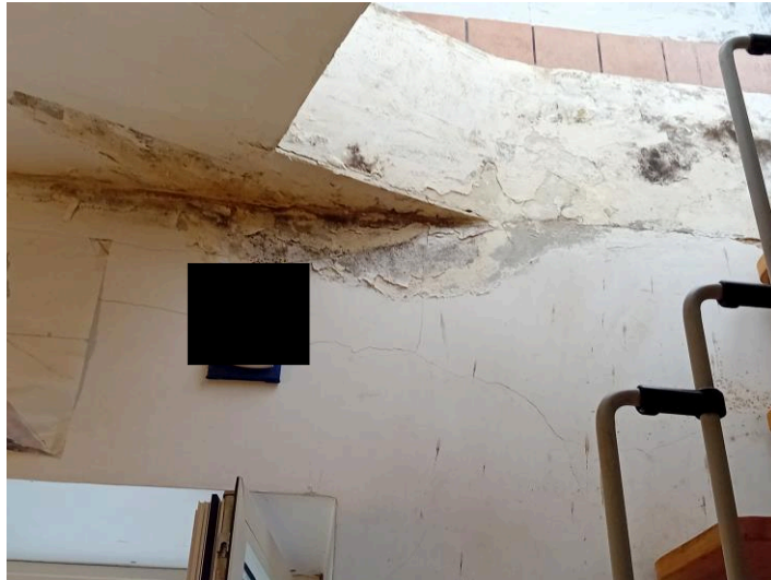
FOTO 34 – Dettaglio della scala con l’accesso al lastrico solare: in evidenza le macchie di umidità sulle pareti e sull’intradosso del solaio
