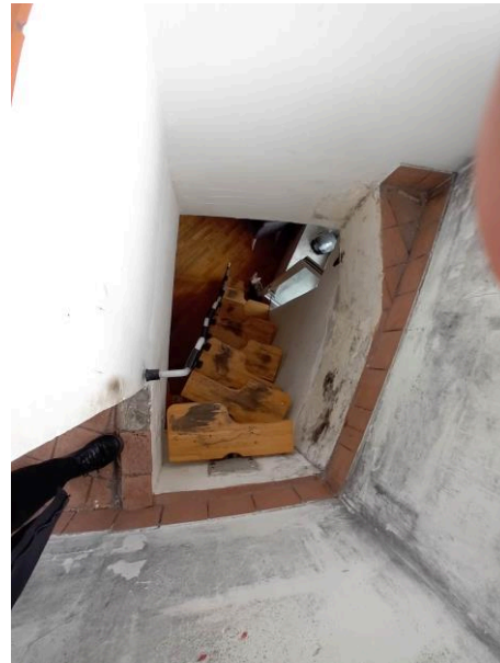
FOTO 34 – Dettaglio della scala con l’accesso al lastrico solare: in evidenza le macchie di umidità sulle pareti e sull’intradosso del solaio
