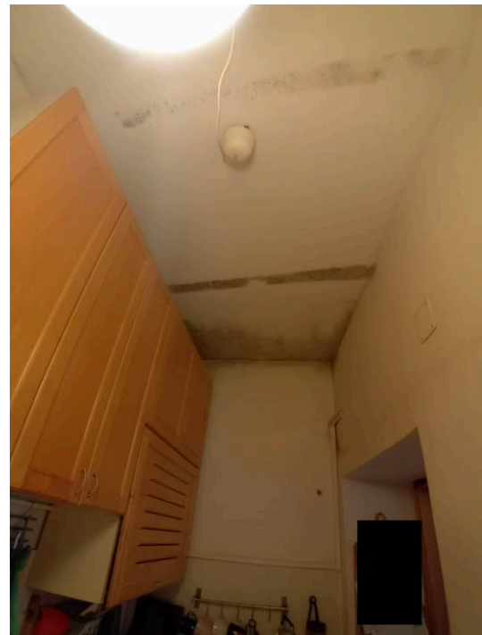
FOTO 17-20 — Dettagli di umidità sul solaio di copertura della cucina
