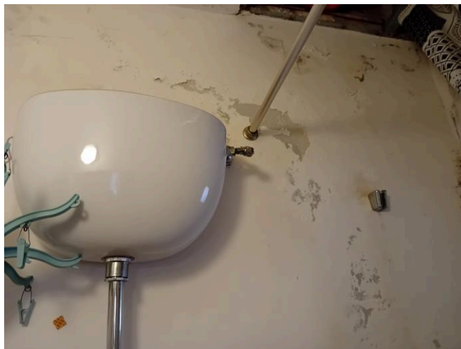
FOTO 29-30 – Il bagno: dettagli di infiltrazioni d’acqua e di umidità diffusa: dalla controsoffittatura (parzialmente demolita) e sulla muratura del fabbricato prospiciente Discesa Sanità
