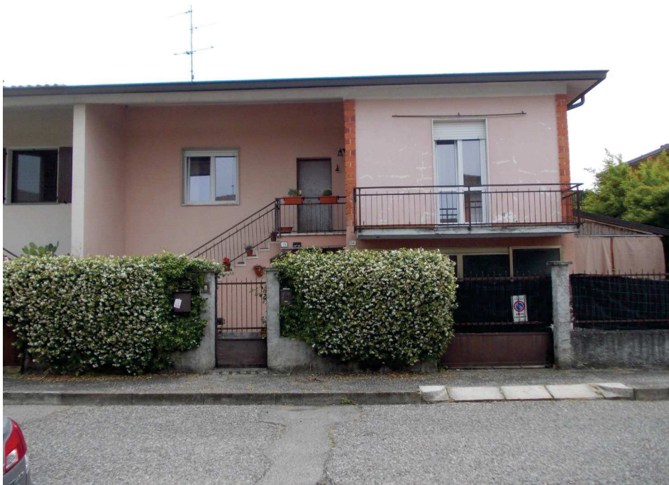
ALLOGGIO FRONTE OVEST
