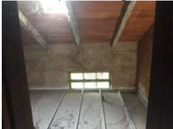
Zona coperta da tetto magazzino
