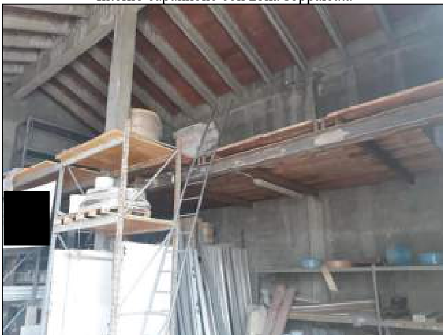
Interno capannone con zona sopralcata
