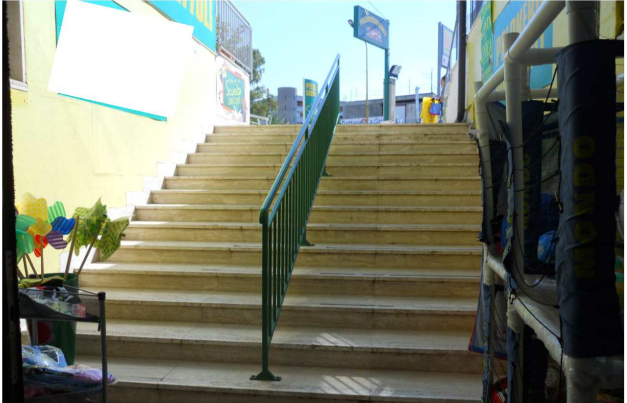
Foto 1 - Scala di ingresso piano 2 (questo cancello di cemento è presente allo stato originale)
