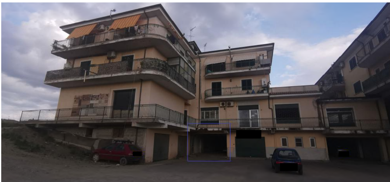
INGRESSO AL LOCALE MAGAZZINO
