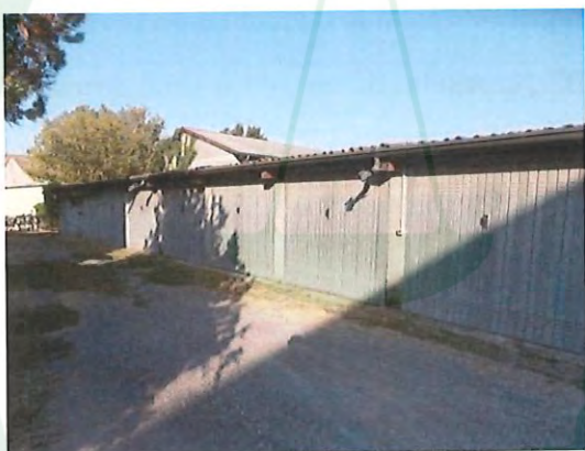
Vista esterna Corpo B autorimesse accessibile da stradello carrabile condominiale sub.15
