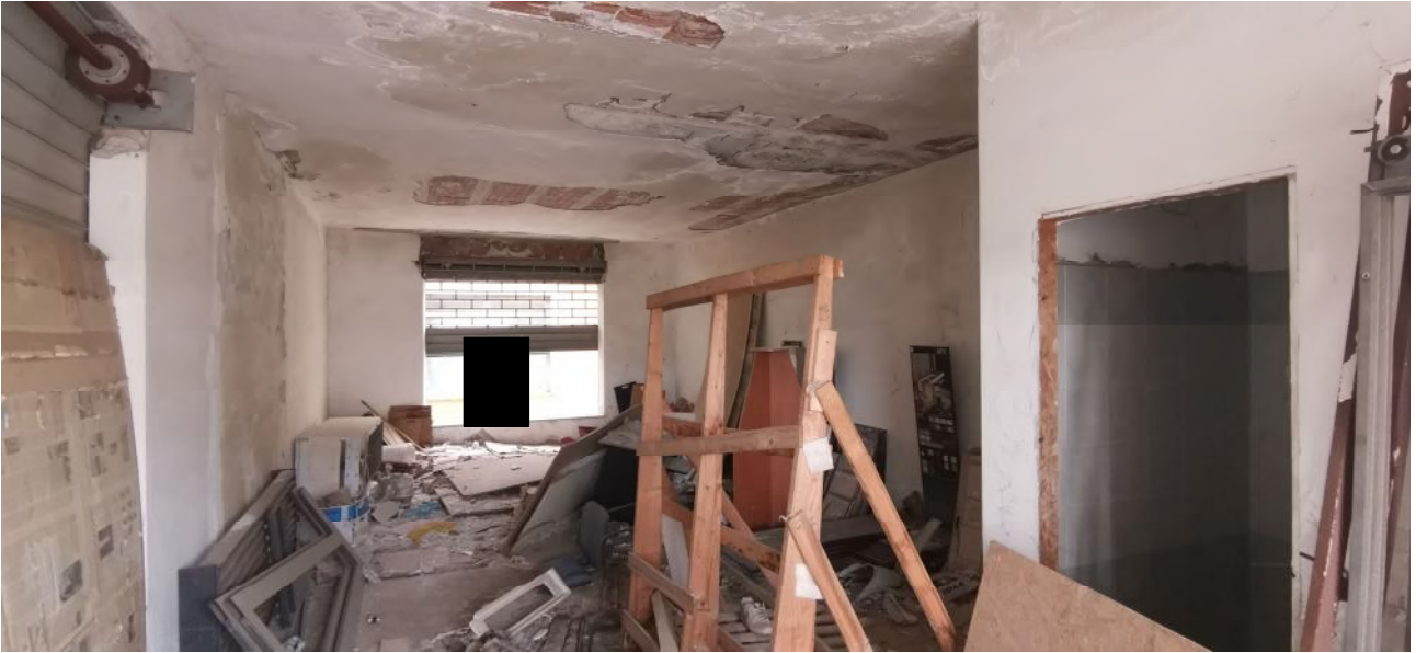
INTERNO DEL LOCALE NEGOZIO
