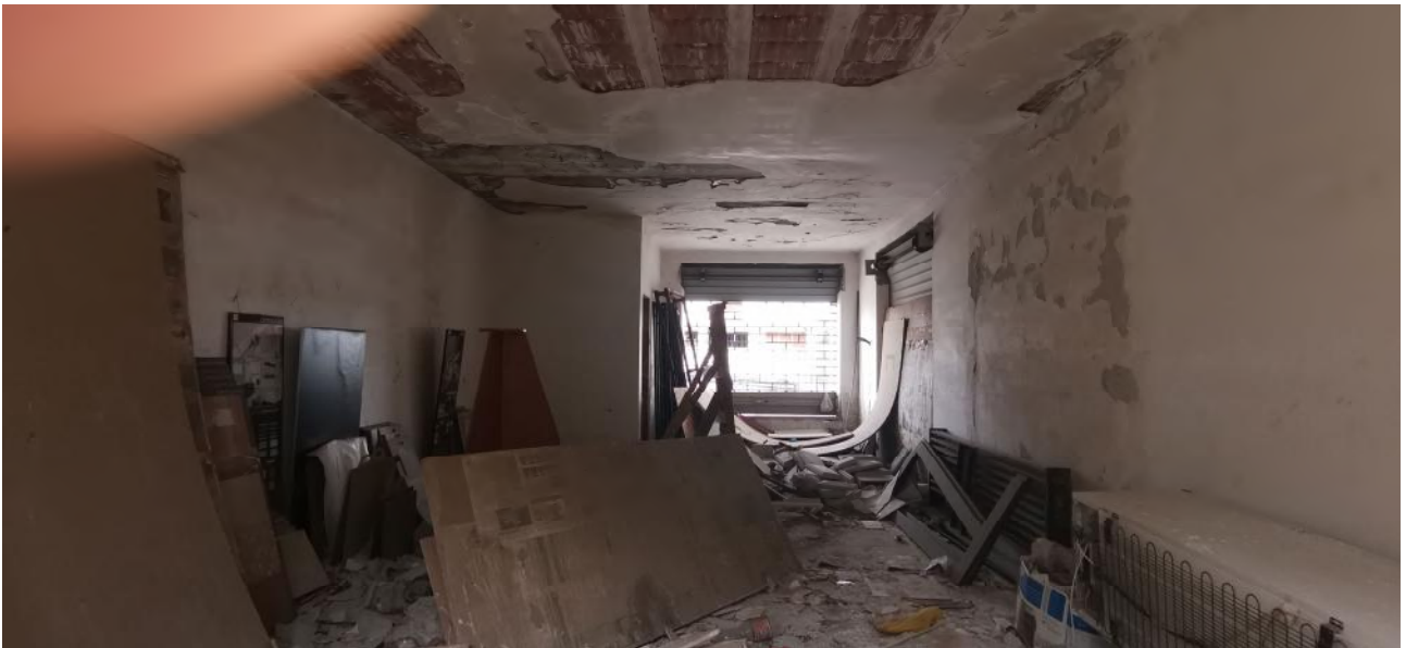
INTERNO DEL LOCALE NEGOZIO
