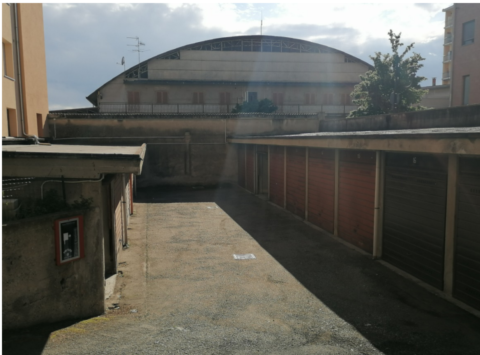
VISTA AUTORIMESSE DAL CORTILE COMUNE
