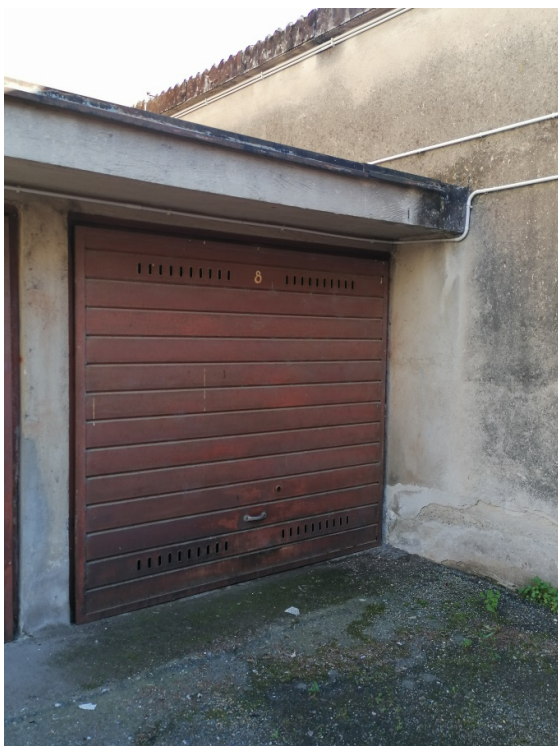
VISTA INTERNA AUTORIMESSA
