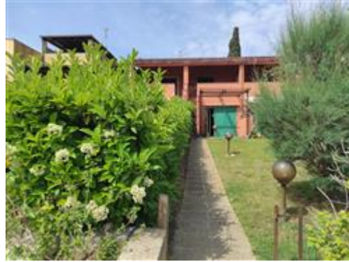
Veduta prospetto Est
