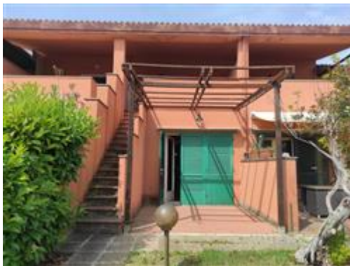
Particolare prospetto Est
