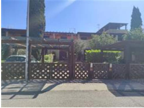
Veduta prospetto Ovest
